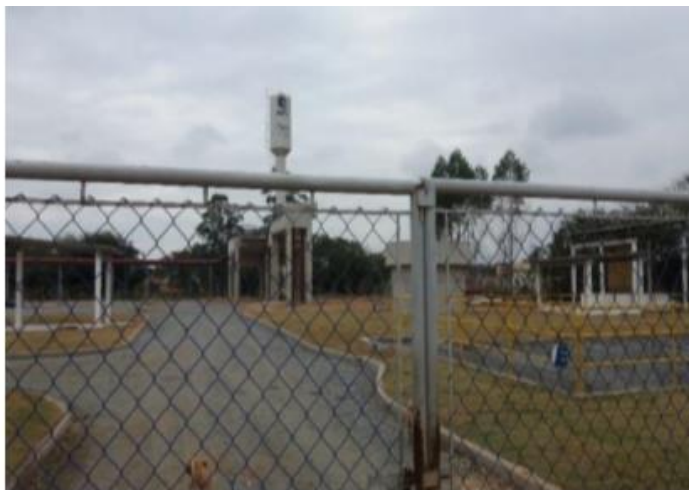
Foto 1 – Portão de acesso
