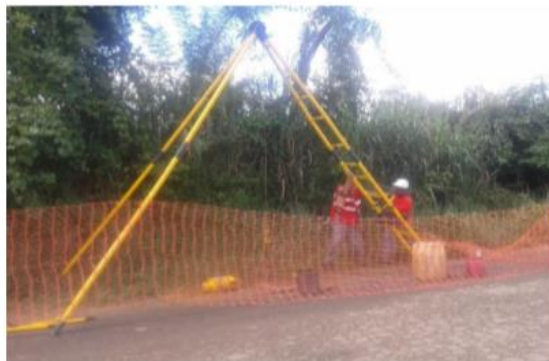
Foto 1 – Realização de serviços de sondagem
