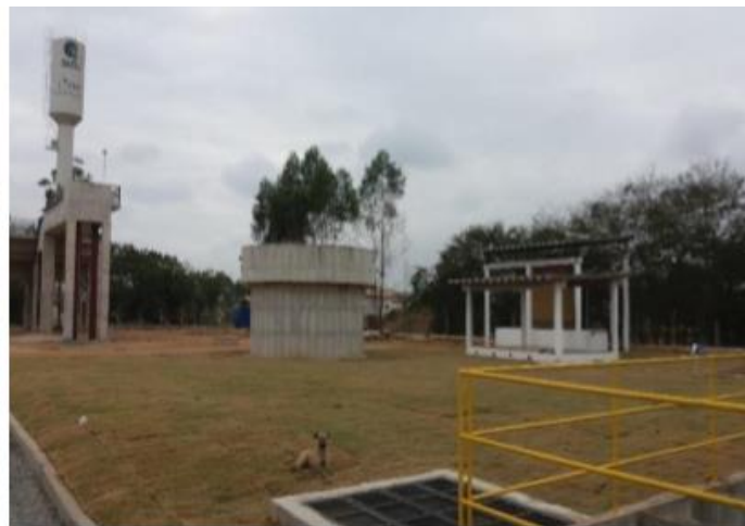
Foto 2 – Tratamento Preliminar, Adensador Suprimido e Unidade de Armazenamento e Dosagem de Hipoclorito de Sódio
