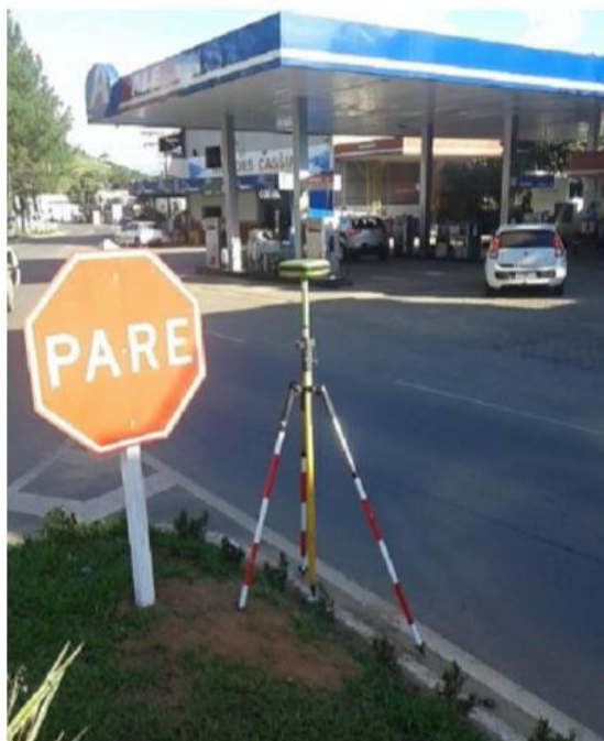
Foto 3– Realização de serviços de topografia
