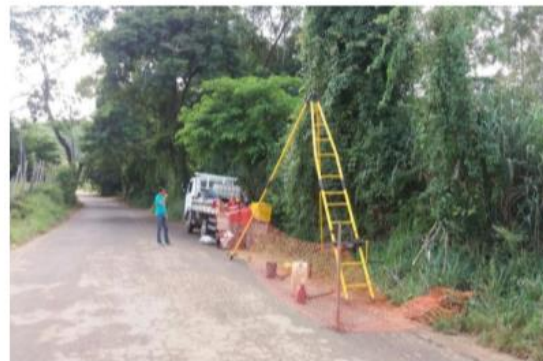
Foto 2– Realização de serviços de sondagem
