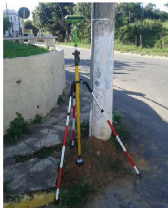
Foto 4– Realização de serviços de topografia
