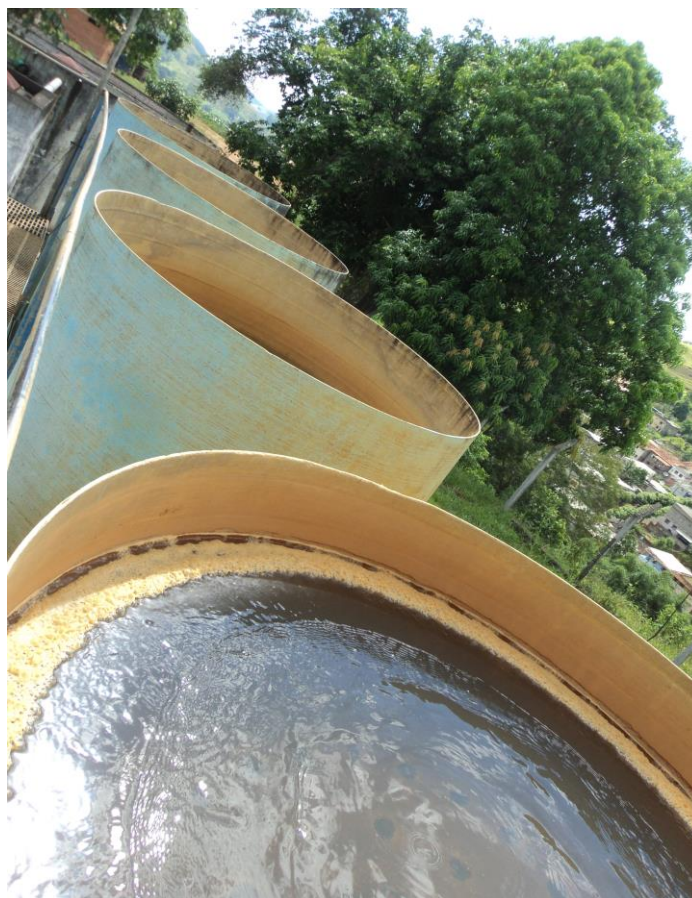
Figura 15 – Flocculador – ETA antiga Fonte: DRZ - Gestão Ambiental
