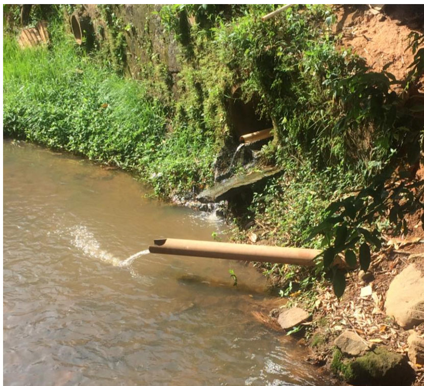
Figura 25 – Lançamento de efluente de esgoto doméstico in natura Fonte: DRZ - Gestão Ambiental
