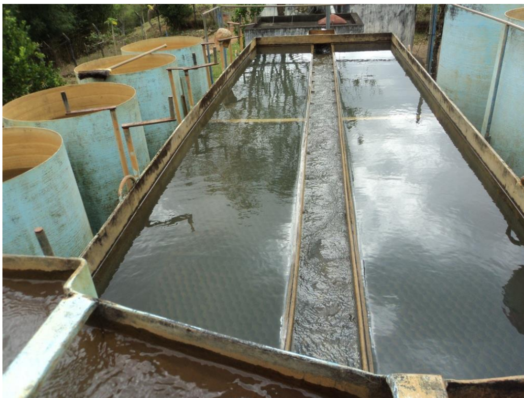
Figura 17 – Decantador – ETA antiga Fonte: DRZ - Gestão Ambiental
