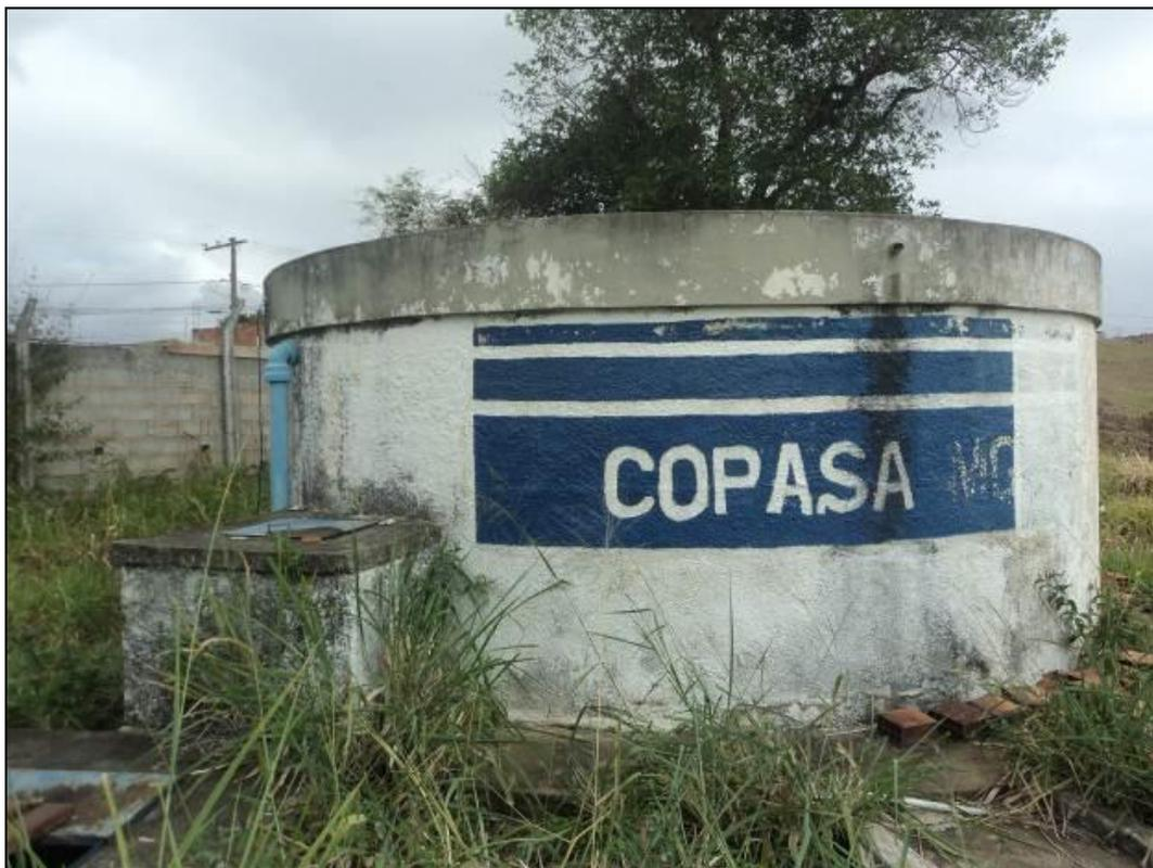
**Figura 32 - Reservatório de água tratada de 100 m<sup>3</sup> - Distrito Sede**
