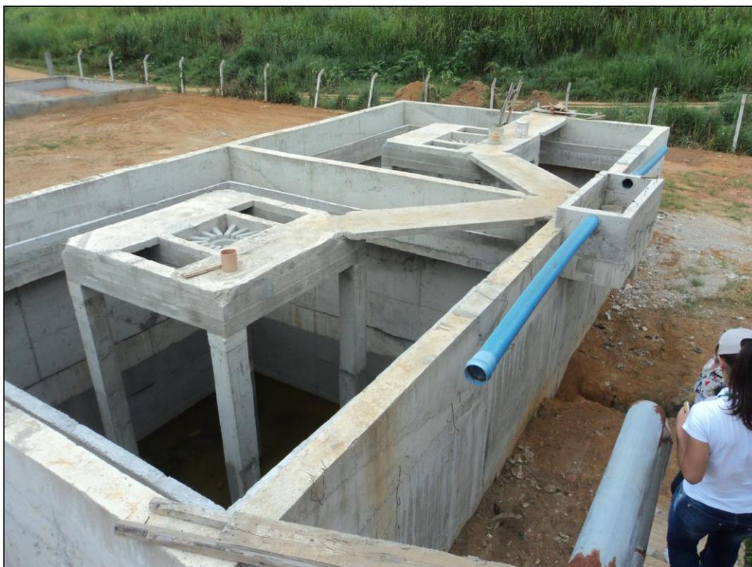
Figura 51 - Reator anaeróbico de fluxo ascendente - UASB
