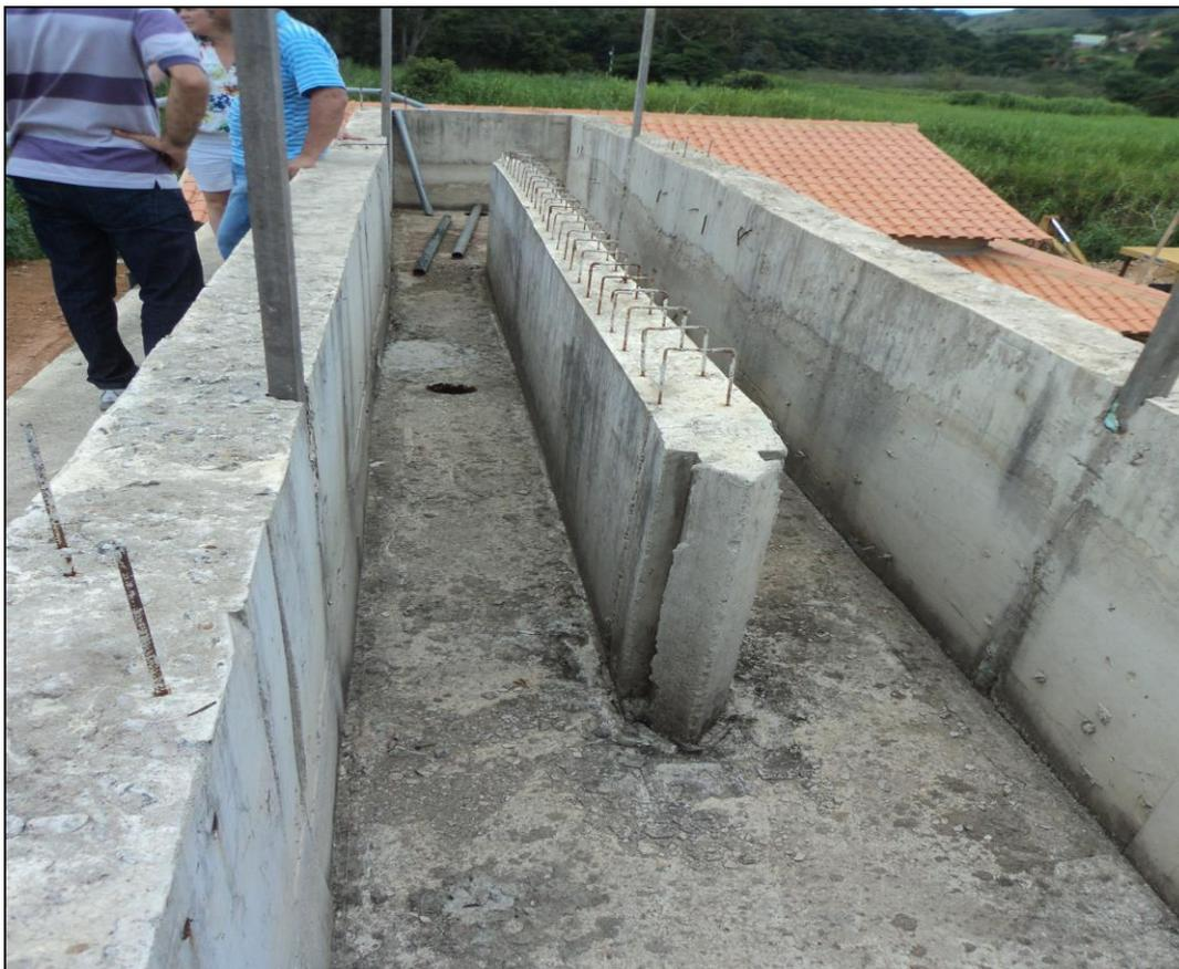
Figura 50 – Canal de entrada / desarenador da ETE.
