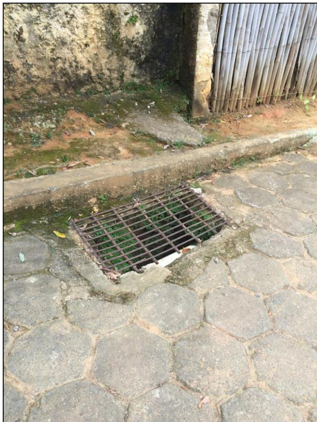
**Figura 67 - Estrutura de captação do tipo grelha no Distrito Sapucaia**
