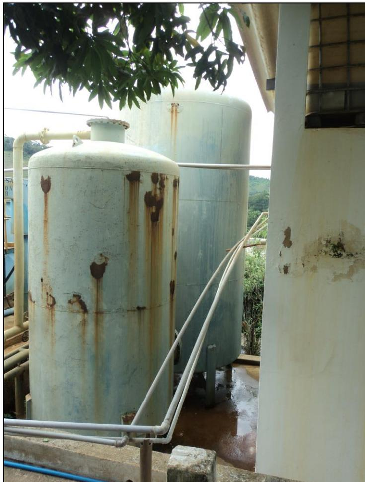
**Figura 28 – Vazamento**
