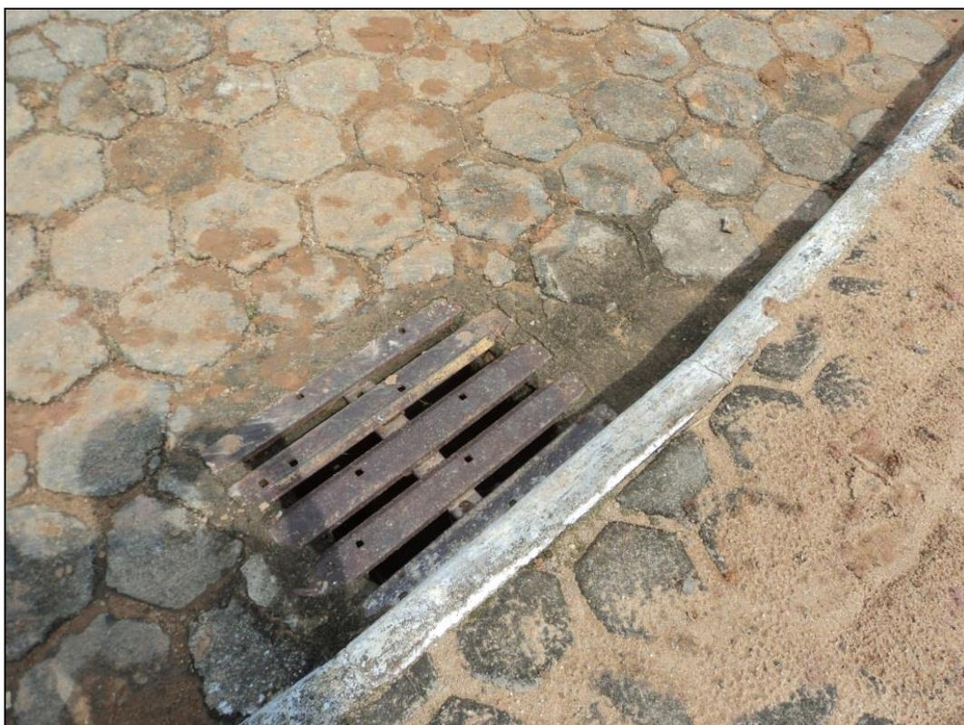
**Figura 63 - Estrutura de captação do tipo grelha no Distrito Sede**
