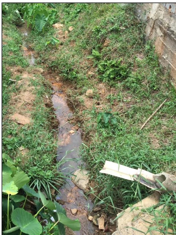
**Figura 69 - Lançamento de efluente de esgoto doméstico em rede de microdrenagem**
