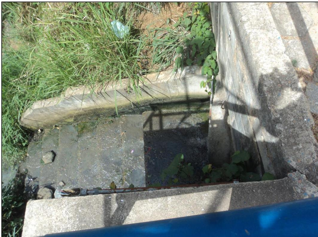
**Figura 70 - Lançamento de efluente de esgoto doméstico em rede de microdrenagem**
