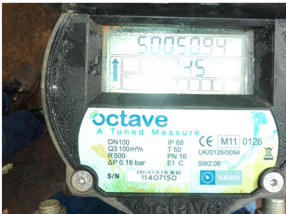
Figura 17 - Macromedidor do Ponto 2 de captação
