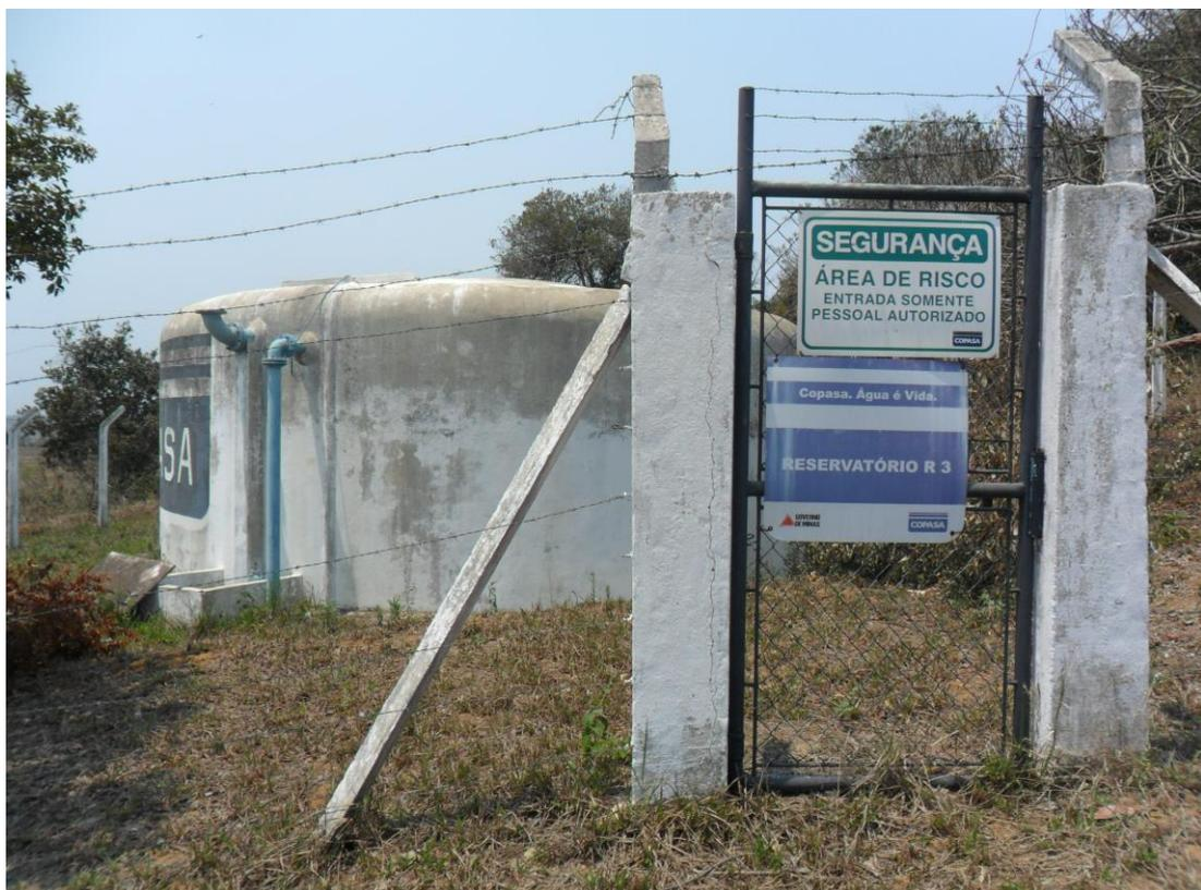
Figura 27 – Reservatório apoiado de 155 m<sup>3</sup>
