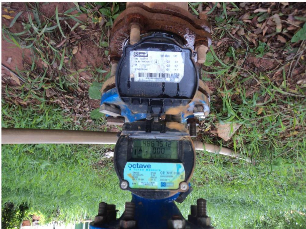
Figura 16 - Macromedidor do Ponto 1 de captação
