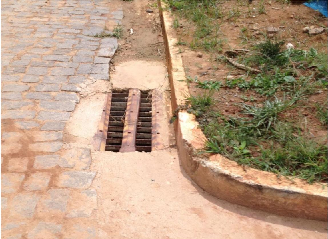
**Figura 34 - Estrutura de captação do tipo grelha**
