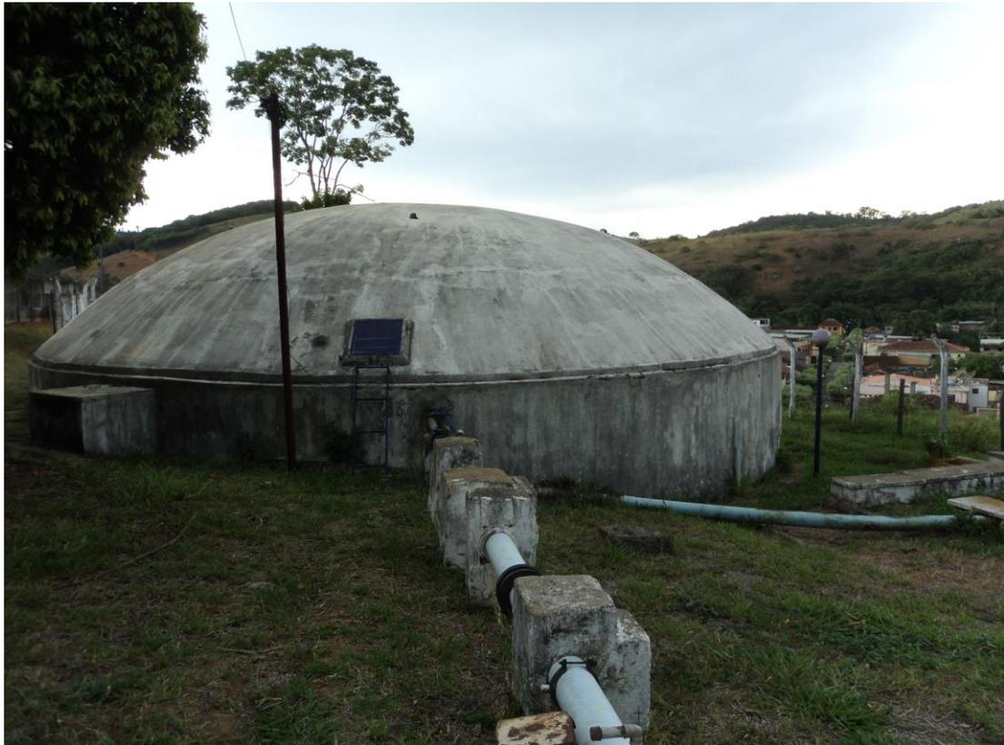
**Figura 28 – Reservatório apoiado de 500 m<sup>3</sup>**
