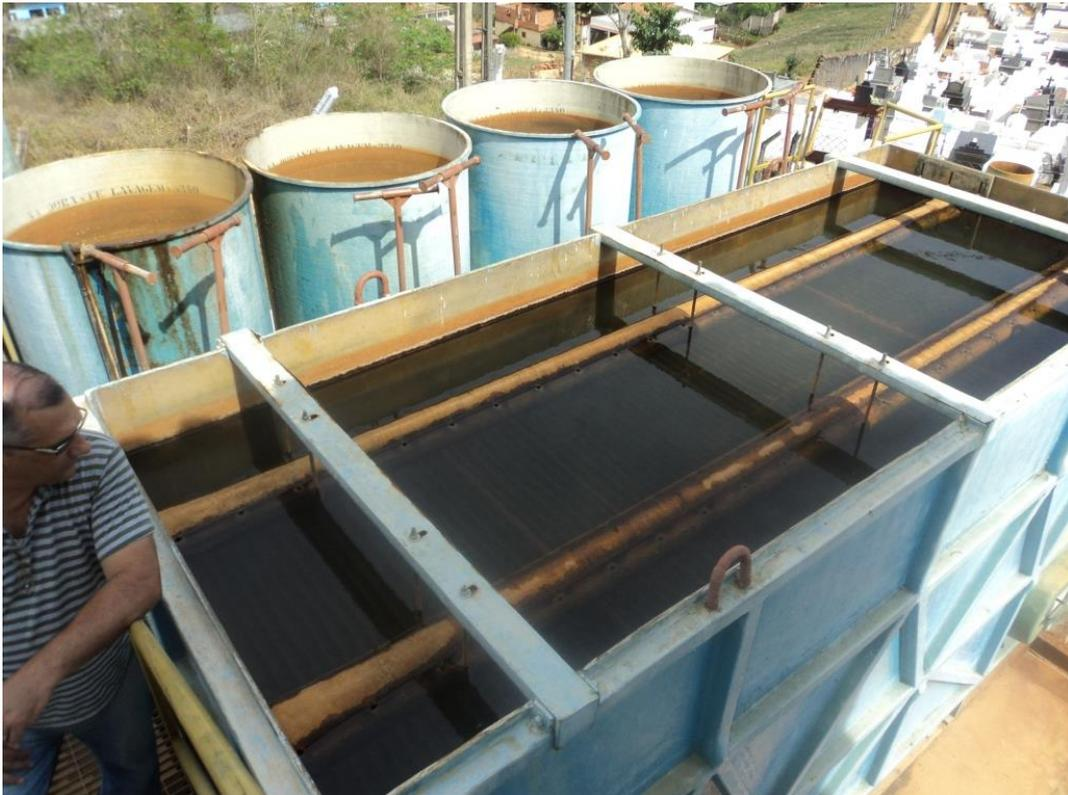
**Figura 25 – Decantador e filtros da estação de tratamento de água**
