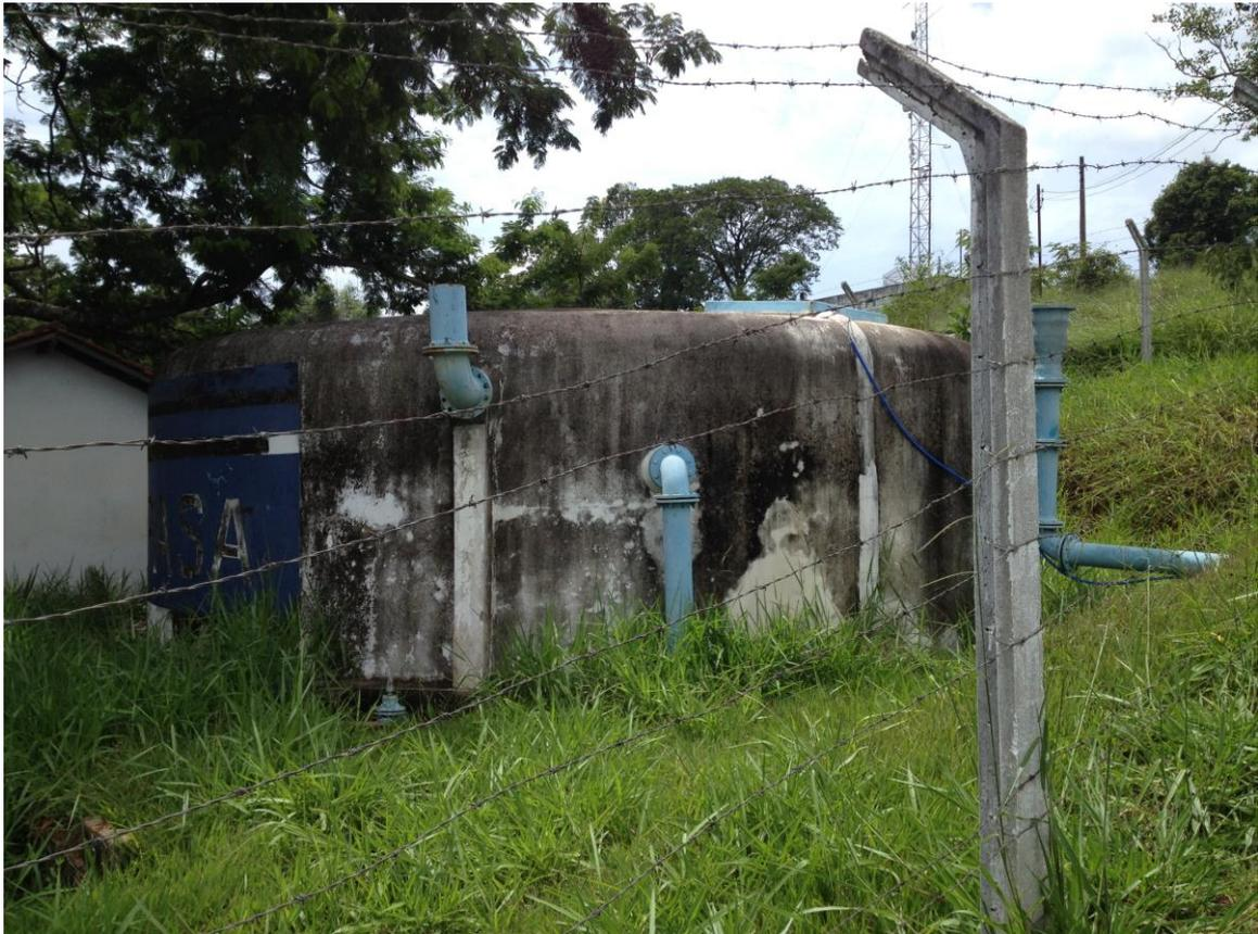
Figura 26 – Tanque de contato de 100 m<sup>3</sup>
