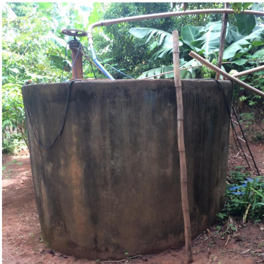
**Figura 14 - Caixa de passagem da água captada no Rio Muriaé**
