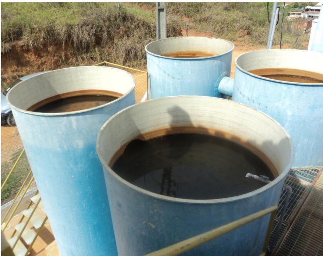
**Figura 24 – Floculador da estação de tratamento de água**
