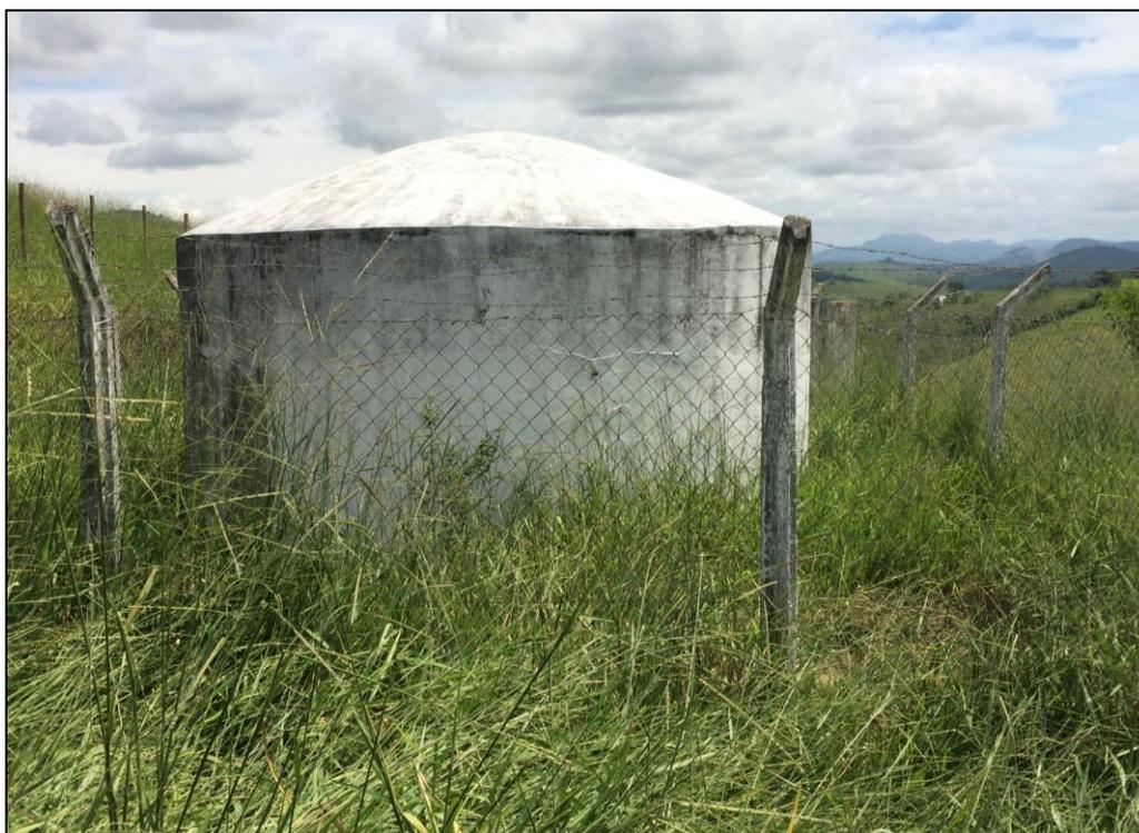
**Figura 26 – Reservatório apoiado (50m³).**
