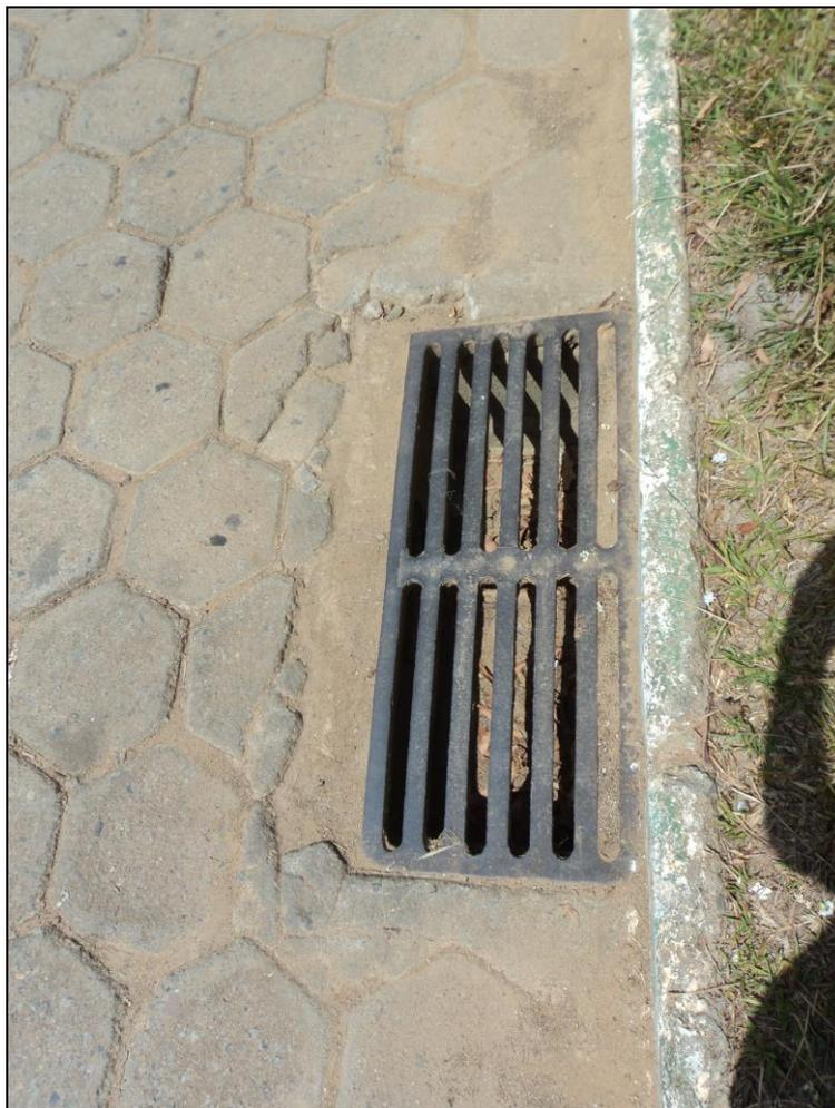
**Figura 65 - Estrutura de captação do tipo grelha no Distrito Sede**
