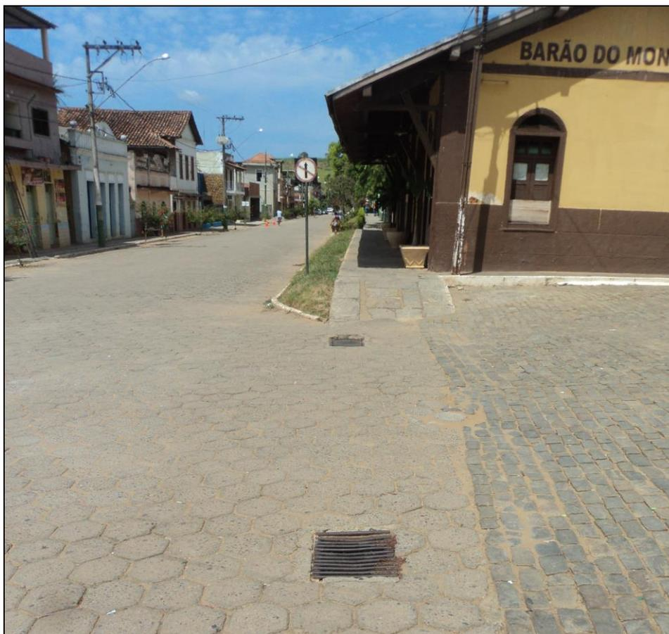
**Figura 66 - Estrutura de captação do tipo grelha no Distrito Sede**
