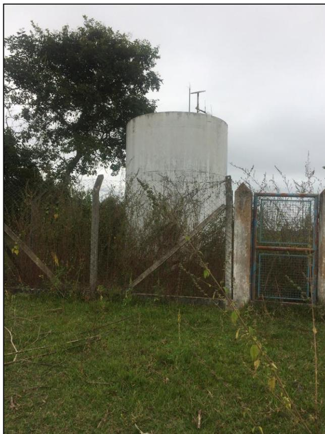
**Figura 53 – Reservatório metálico apoiado (30m<sup>3</sup>) – Distrito de Vardieiro.**
