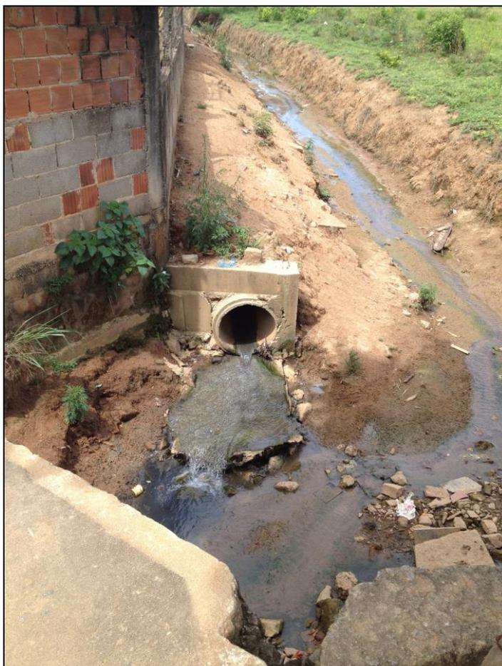
**Figura 74 - Lançamento de efluente de esgoto doméstico em rede de microdrenagem**
