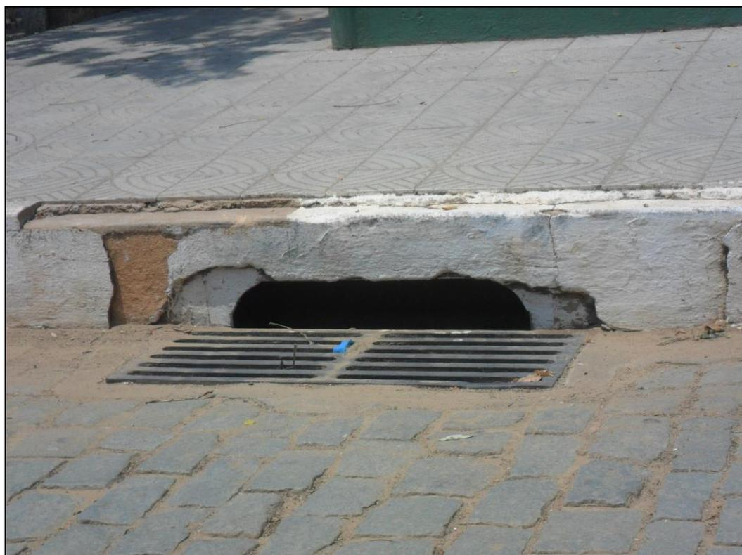
**Figura 67 - Estrutura de captação do tipo lateral no Distrito Sede**
