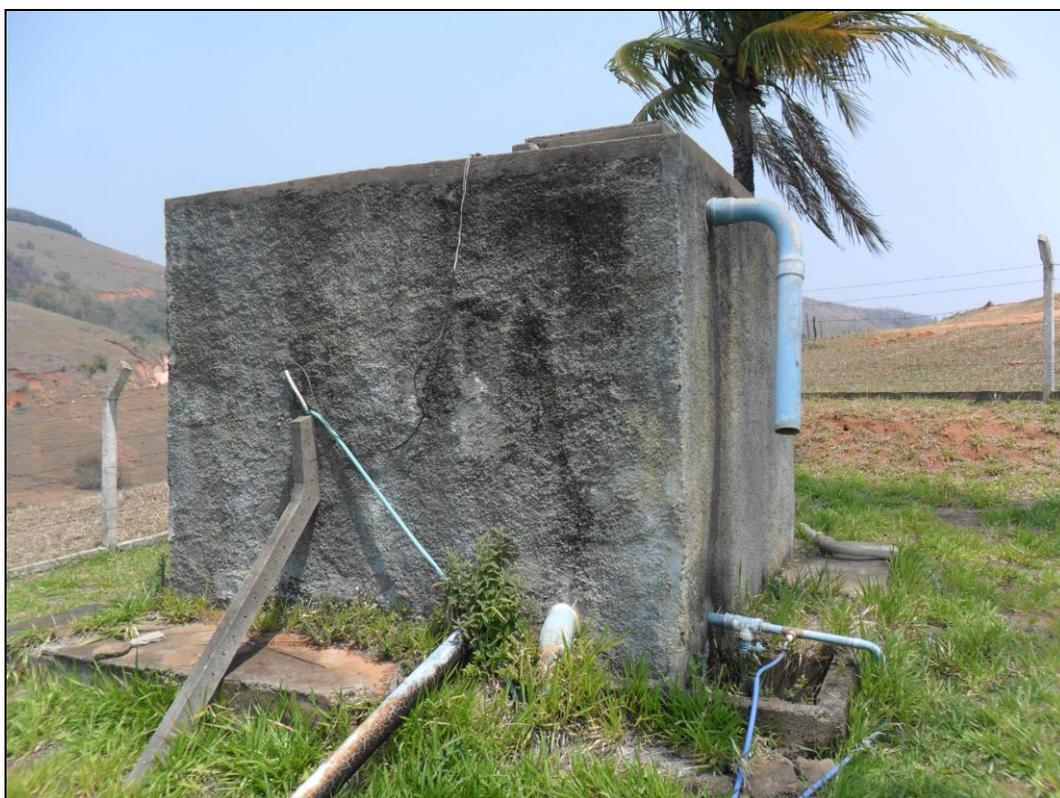
**Figura 25 – Reservatórios ETA – Tanque de contato (30m³).**
