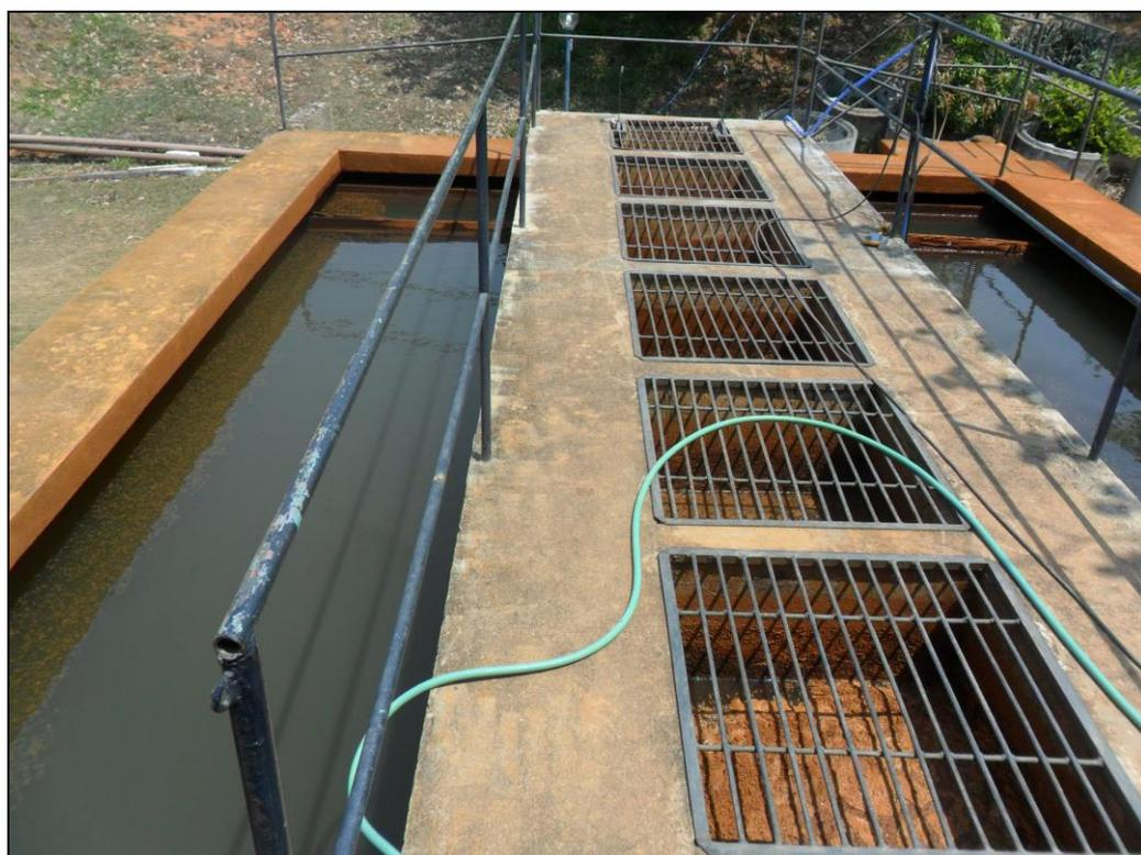
**Figura 17 - Flocculador e decantador – ETA.**
