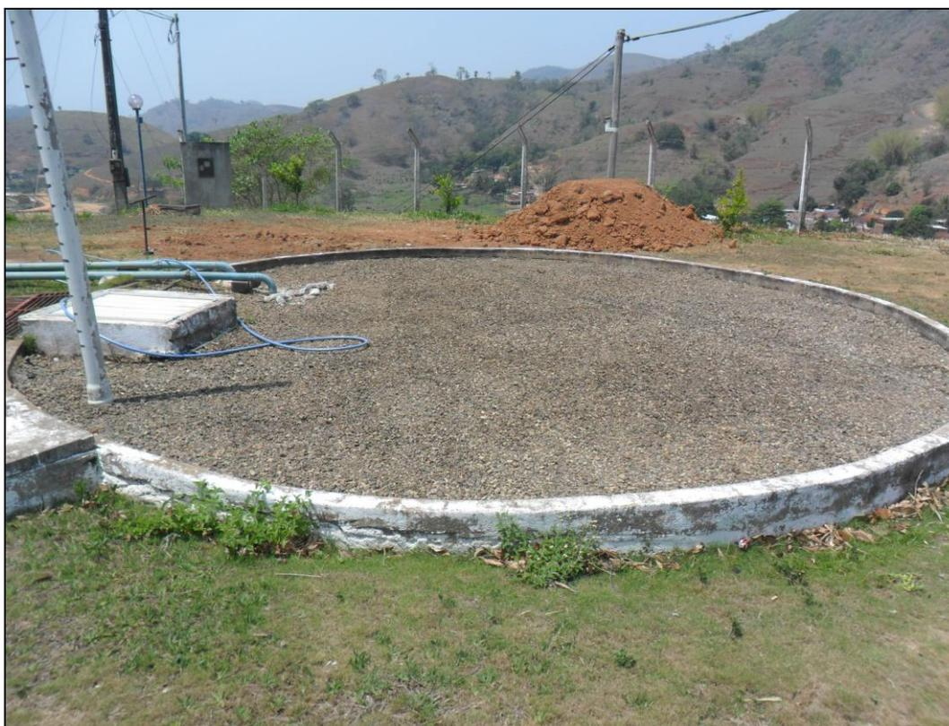
Figura 23 - Reservatório enterrado ETA concreto (100m³).
