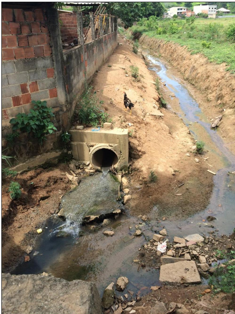
**Figura 57 – Emissário de esgoto e drenagem.**
