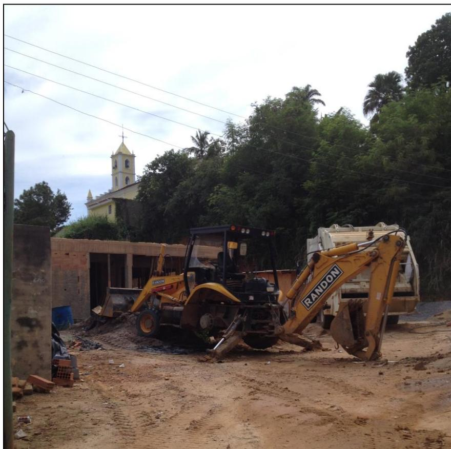
**Figura 85 – Retroescavadeira utilizada para coleta de RCC.**
