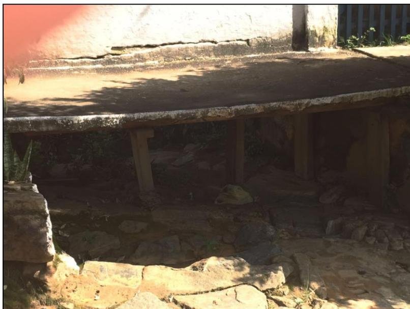
**Figura 120 – Dispositivo de captação lateral– Distrito Piacatuba**
