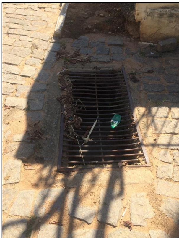
**Figura 119 – Dispositivo de captação em grelha – Distrito Piacatuba**
