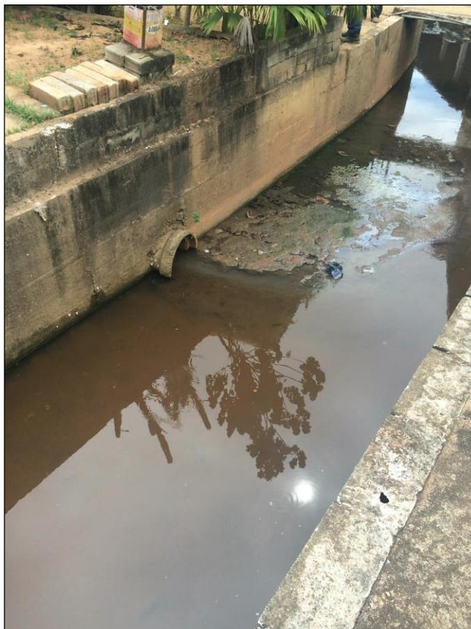
**Figura 130 – Lançamento de esgoto em galeria de águas pluviais – Distrito de Ribeiro Junqueira.**
