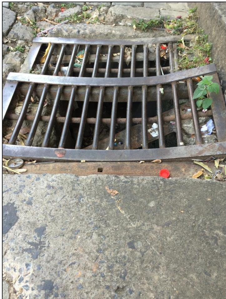
**Figura 114 - Estrutura de captação do tipo grelha no Distrito Sede**
