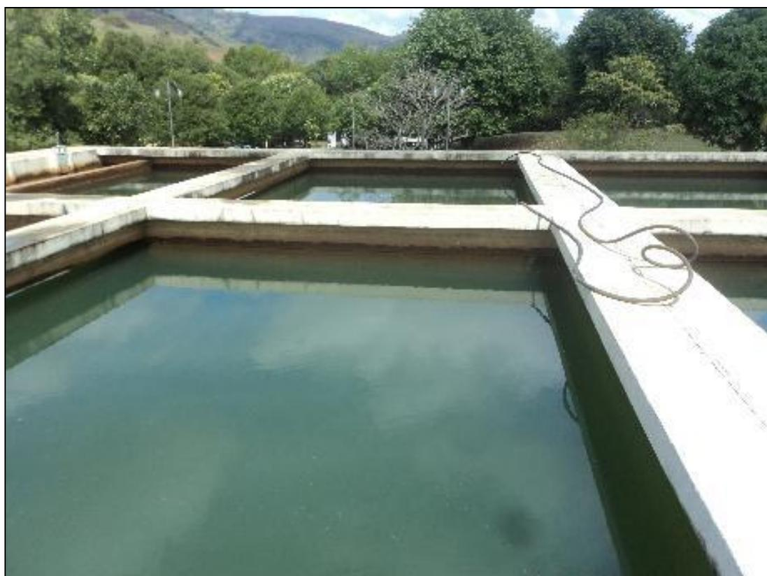
**Figura 33 – Estrutura de tratamento – Decantador – Distrito Sede**
