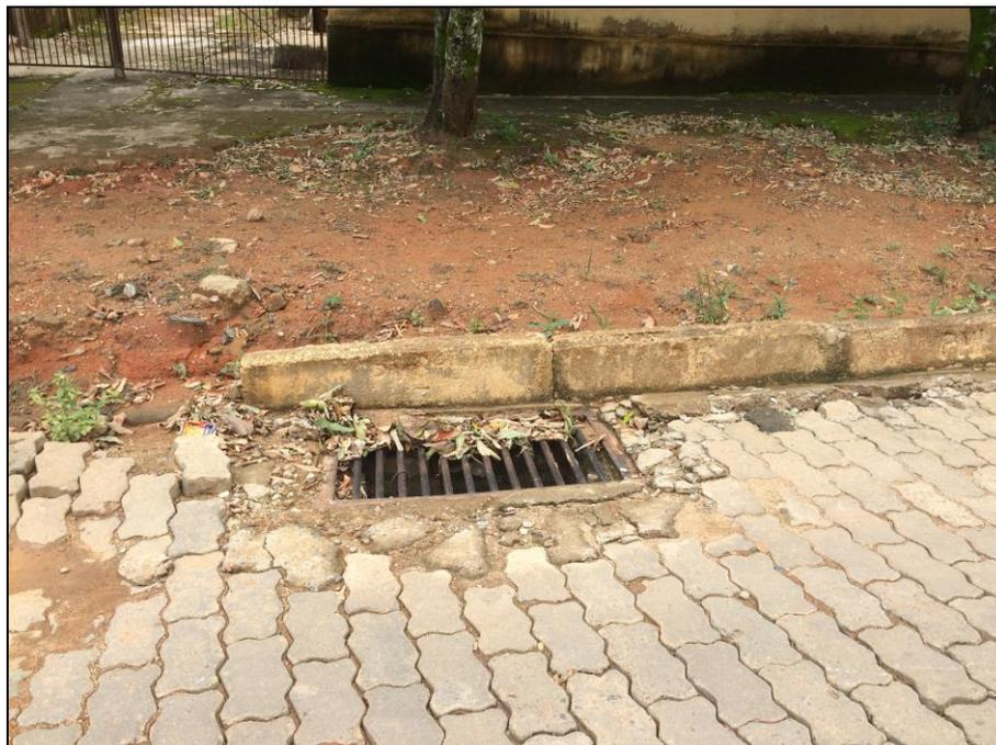
**Figura 123- Dispositivo de captação em grelha – Distrito Providência.**
