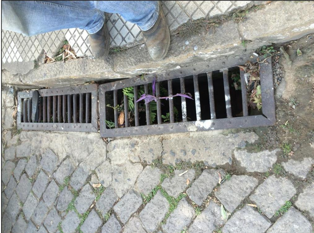
**Figura 113 - Estrutura de captação do tipo grelha no Distrito Sede**
