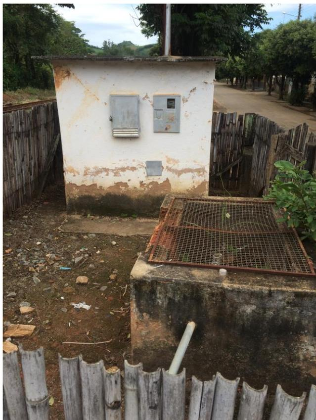
**Figura 75 - Poço 1 de captação de água bruta – Distrito Providência**
