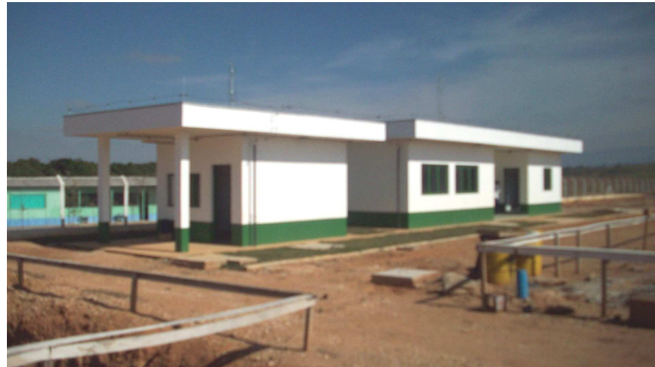
Portaria – Casa Operação
