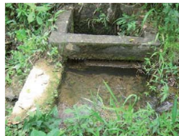
Figura 14 – Nascente Beltino de Souza vista 1.
