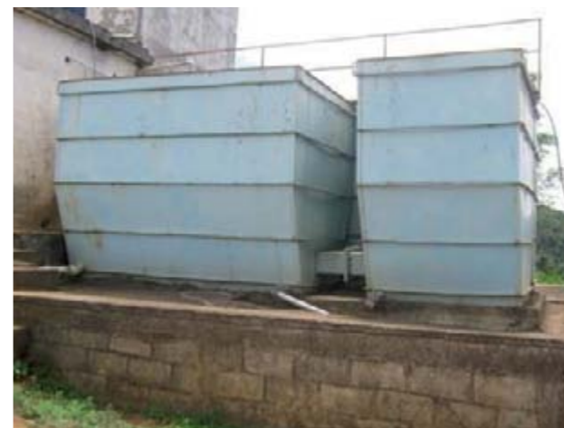
Figura 30 – ETA desativada - vista 1
