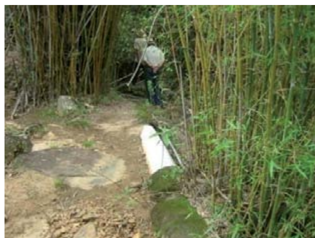
Figura 20 – Captação do Córrego Beltino de Souza.
