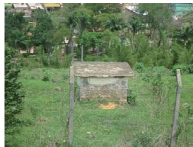
Figura 34 – ETA desativada - vista 5
