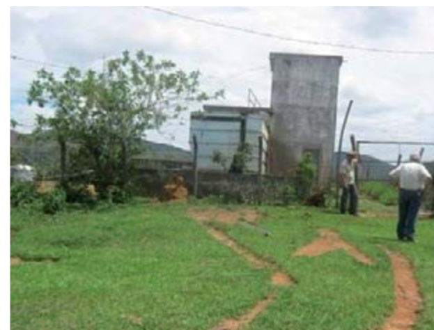
Figura 32 – ETA desativada - vista 3
