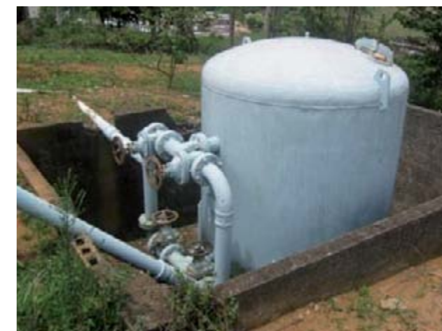
Figura 35 – ETA desativada - vista 6
