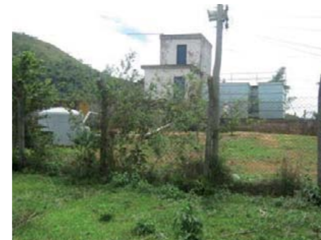
Figura 31 – ETA desativada - vista 2
