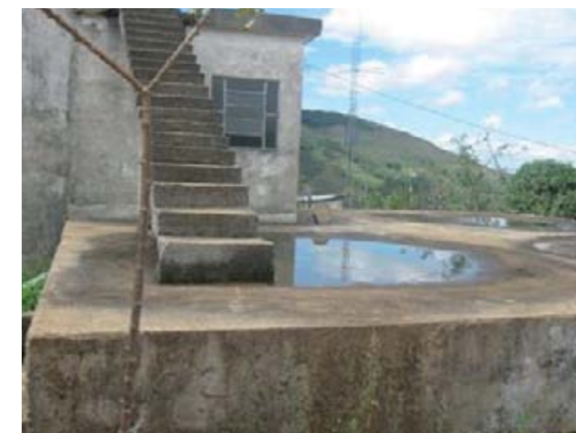
Figura 33 – ETA desativada - vista 4
