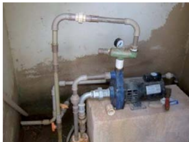
Figura 34 – Poço raso inativo.
