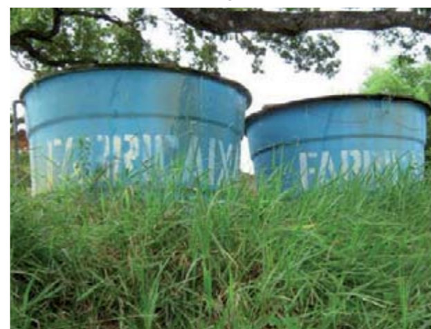
Figura 53 – Reservatório poço tubular profundo - vista 1
