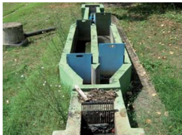
Figura 60 – Sistema primário da ETE.
