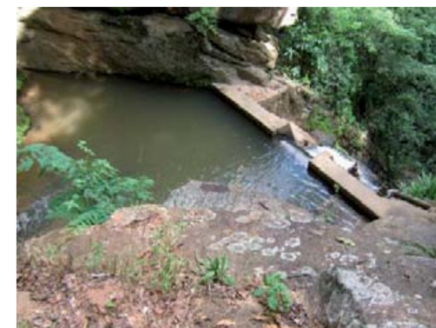
Figura 22 – Captação no Córrego Buracão
