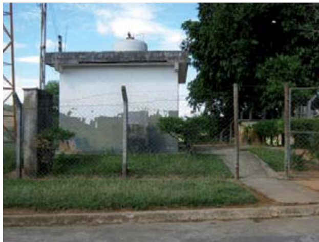
Figura 43 – Vista da entrada da ETA 2 no Bairro do Cruzeiro.
