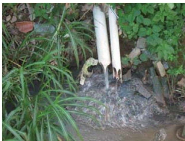
Figura 66 – Vista da tubulação de lançamento de esgoto.
