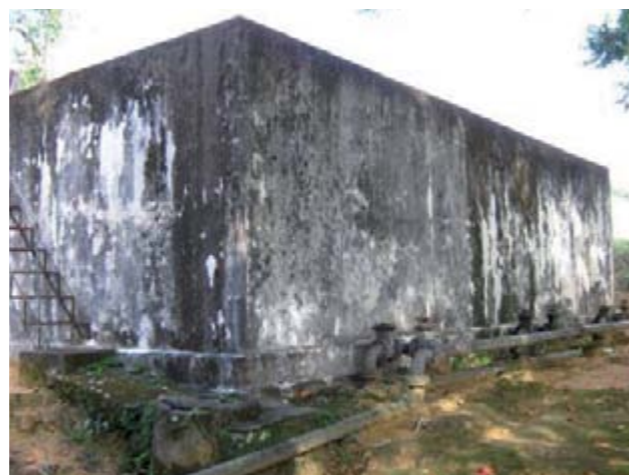
Figura 50 – Reservatório apoiado.
