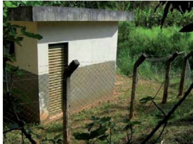
Figura 26 – Vista do abrigo do sistema de captação.
