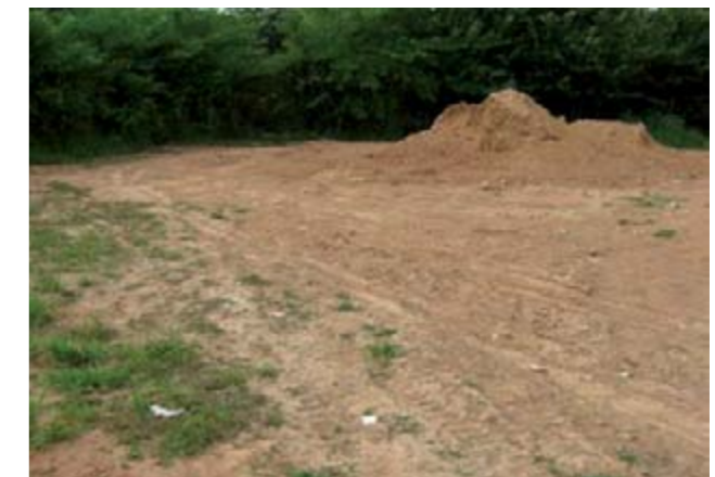
Figura 72 – Vista do Aterro controlado.
