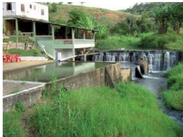
Figura 30 – Construção as margens do Córrego da Prata.
