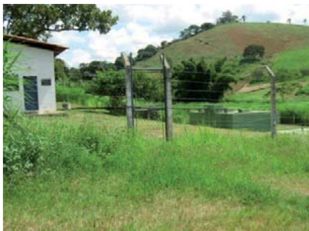
Figura 59 – Vista da Estação de Tratamento de Esgoto.
