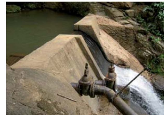
Figura 24 – Vista da barragem de nível no Córrego Buracão
