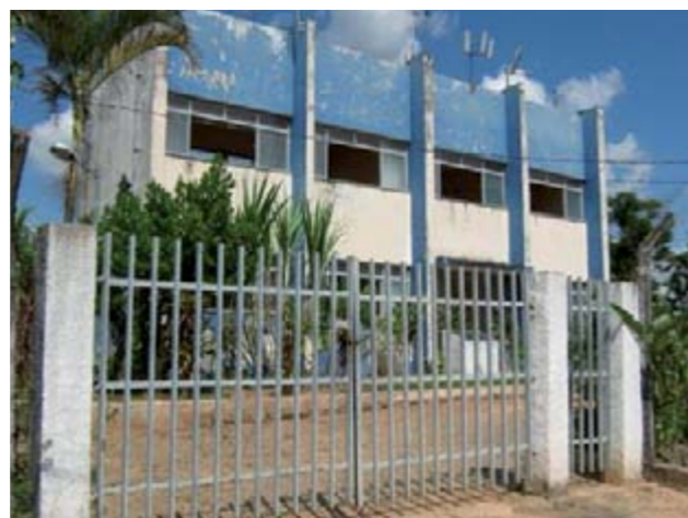
Figura 35 – Vista da ETA 1 no bairro do Rosário.
