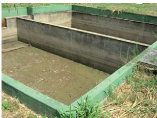
Figura 63 – Leito de secagem – vista 1.
