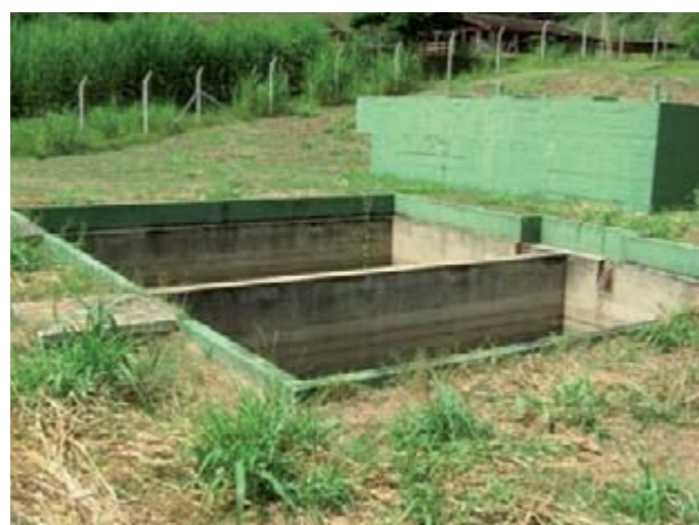
Figura 64 – Leito de secagem – vista 2.
