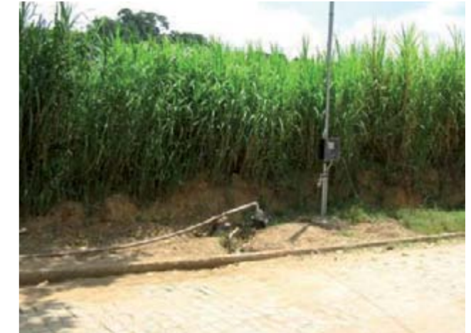
Figura 31 – Localização do Poço tubular profundo.
