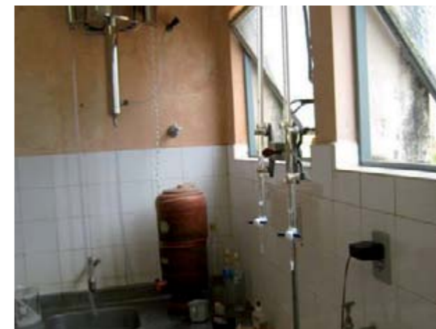
Figura 40 – Laboratório da ETA 1.
