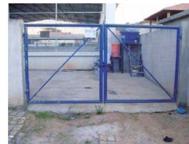
Figura 24 – Acesso ao poço tubular.
