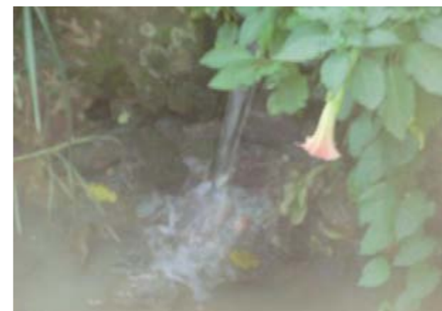
Figura 27 – Local de descarga de esgoto doméstico.
