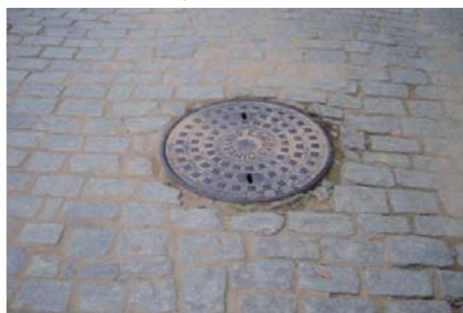
Figura 26 – Poço de visita da rede de esgoto.
