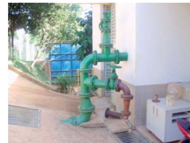
Figura 18 – Vista da área interna.
