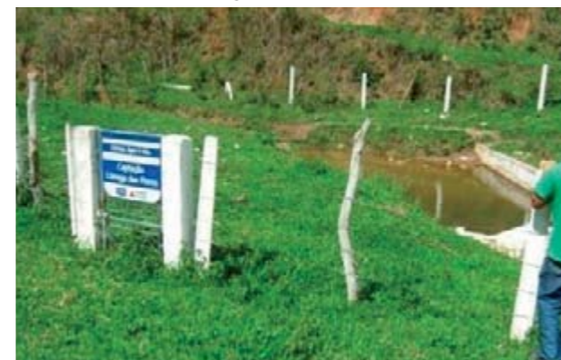
Figura 21 – Captação córrego das Flores - vista 1
