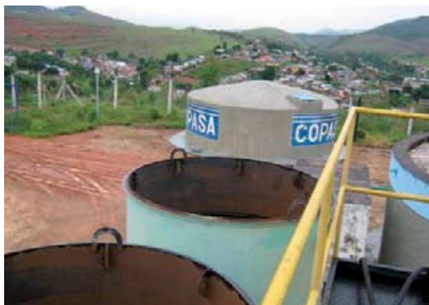
Figura 35 – Vista do reservatório ao fundo.
