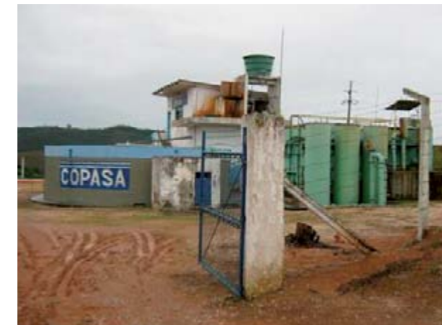
Figura 29 – Acesso a ETA.
