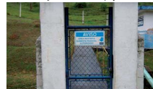
Figura 22 – Acesso a Captação.
