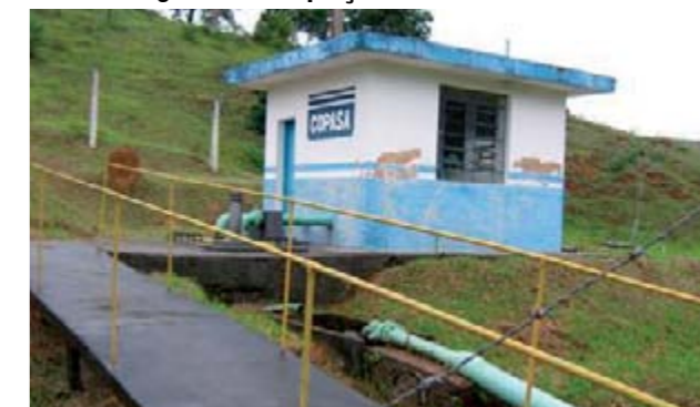
Figura 24 – Captação Bela Itália - vista 2.
