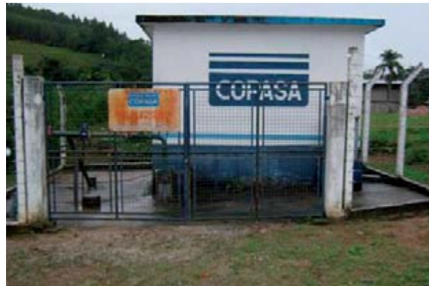
Figura 25 – Poço tubular profundo - vista 1
