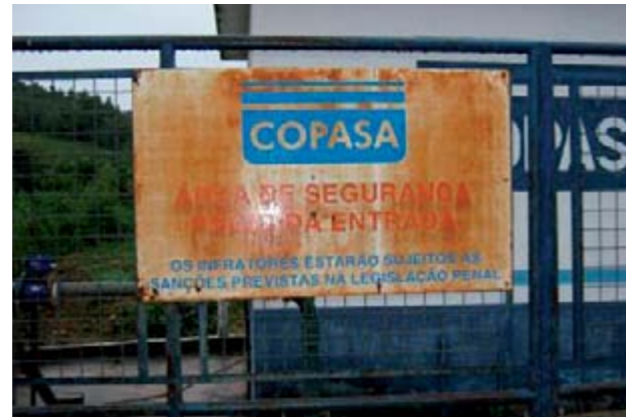
Figura 26 – Poço tubular profundo - vista 2.
