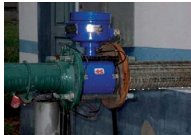
Figura 28 – Poço tubular profundo - vista 4.
