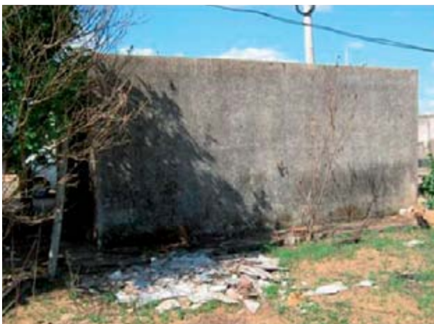
Figura 31 – Vista do reservatório desativado do bairro Rosário.
