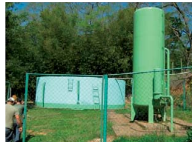
Figura 29 – Reservatório anexo à ETA.
