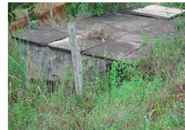
Figura 38 – Res. Nascente Aprígio - vista 2.
