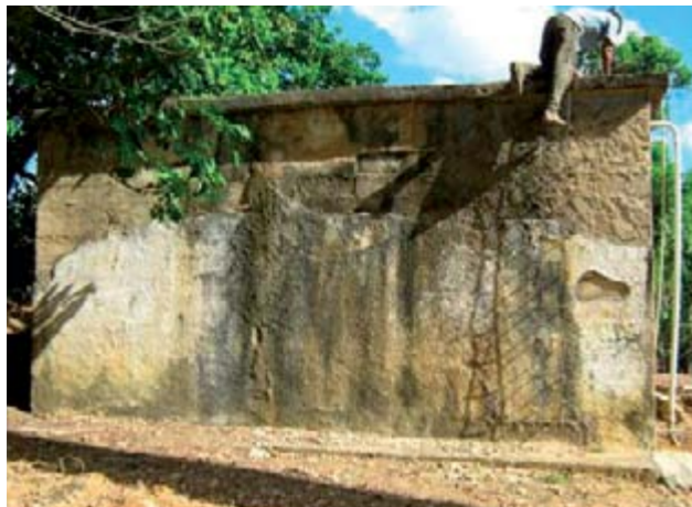
Figura 42 – Reservatório Poço 3 vista 1.
