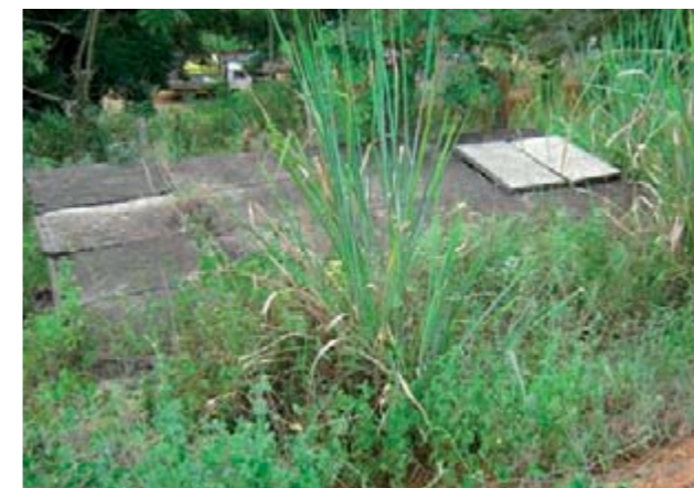
Figura 37 – Res. Nascente Aprígio - vista 1.
