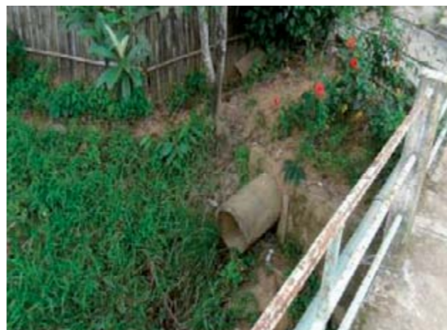
Figura 47 – Despejo de águas pluviais vista 2
