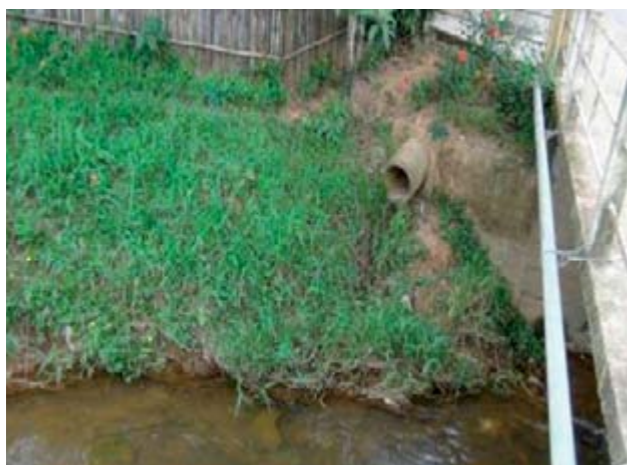
Figura 46 – Despejo de águas pluviais vista 1
