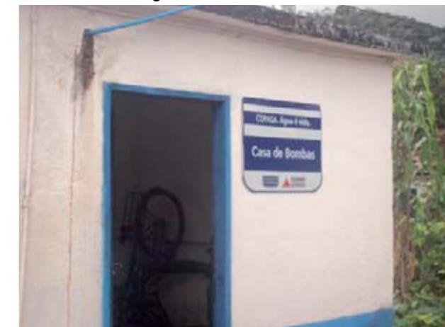
Figura 32 – Casa de bomba
