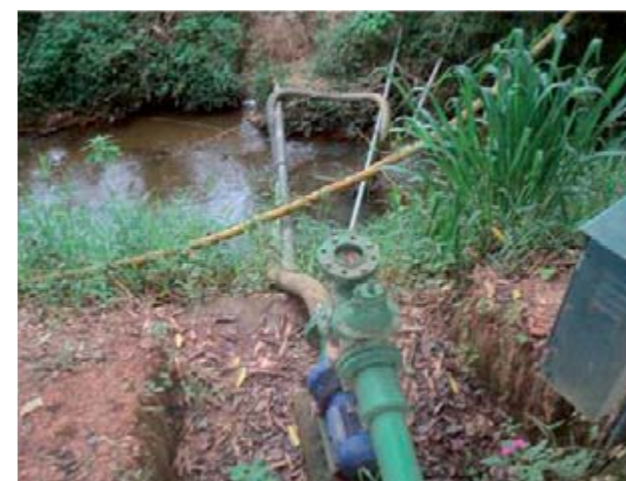
Figura 23 – Captação no córrego Limeira..
