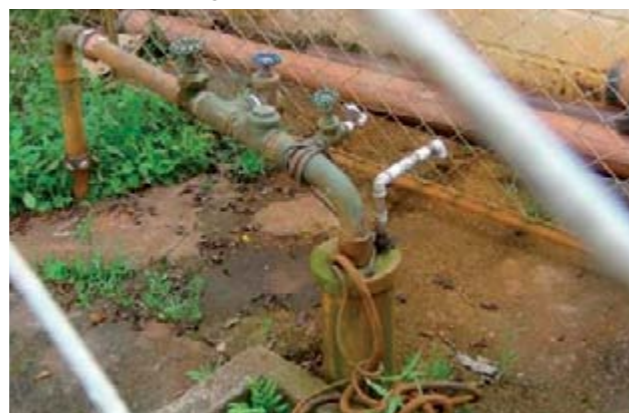
Figura 28 – Poço tubular profundo inativo - vista 2.
