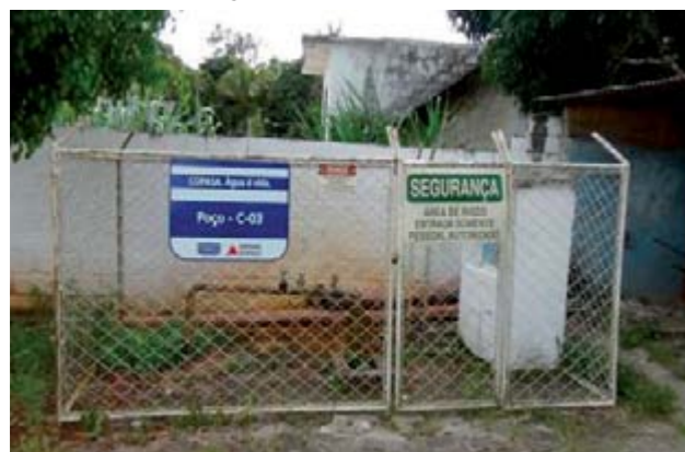
Figura 27 – Poço tubular profundo inativo - vista 1.
