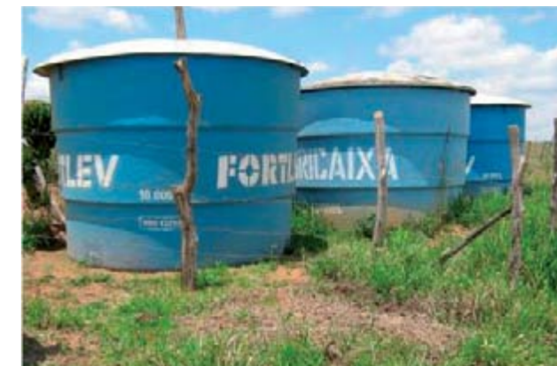
Figura 42 – Detalhe dos reservatórios.
