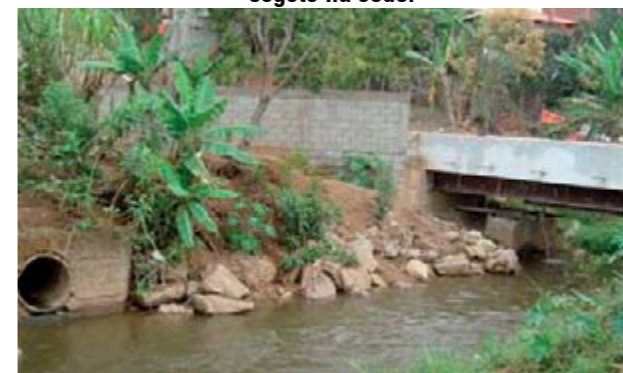
Figura 45 – Detalhe das tubulações de águas pluviais e esgoto na sede.
