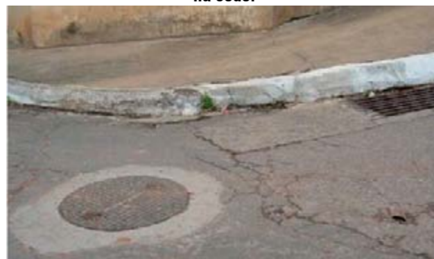
Figura 44 – Presença de PV e boca de lobo na sede.
