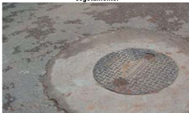
Figura 43 – Tampão do poço de visita (PV) do sistema de esgotamento.
