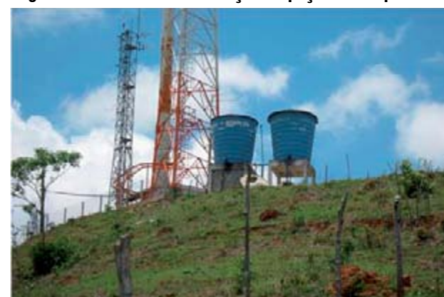
Figura 39 – Centro de reservação do poço tubular profundo.
