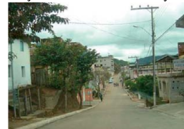
Figura 54 – Inexistência do sistema de microdrenagem.
