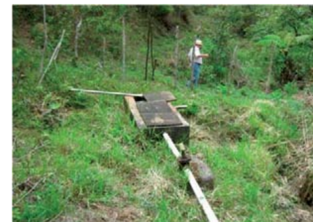
Figura 28 – Cerca de proteção.
