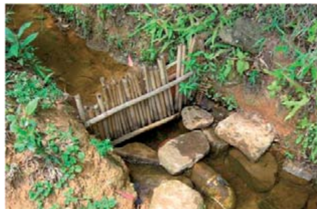
Figura 32 – Captação de água.
