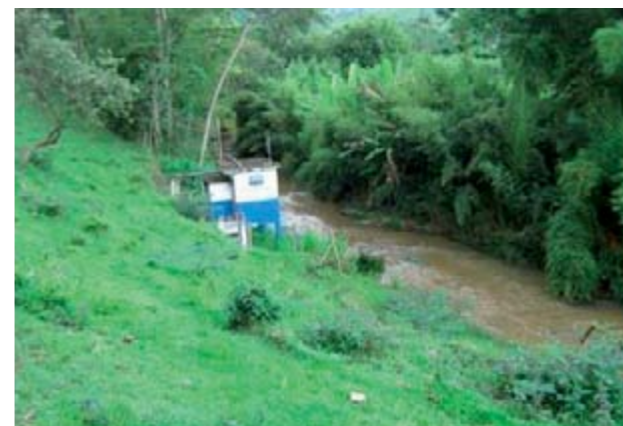
Figura 16 – Rio Pomba – estação elevatória vista 1.
