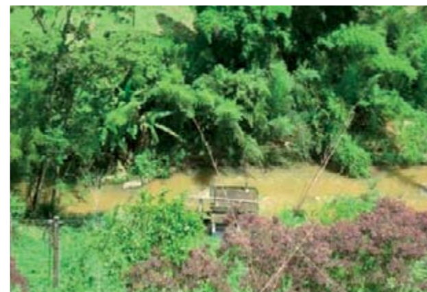
Figura 20 – Vista da Captação e EEAB
