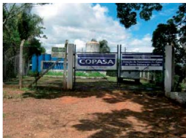
Figura 22 – Vista da entrada da ETA.
