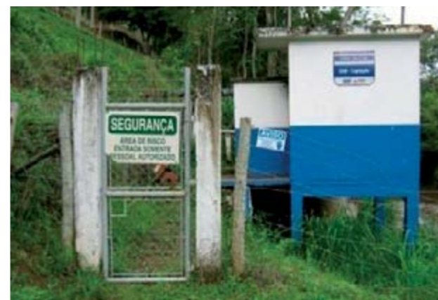
Figura 18 – EEAB – Estação Elevatória
