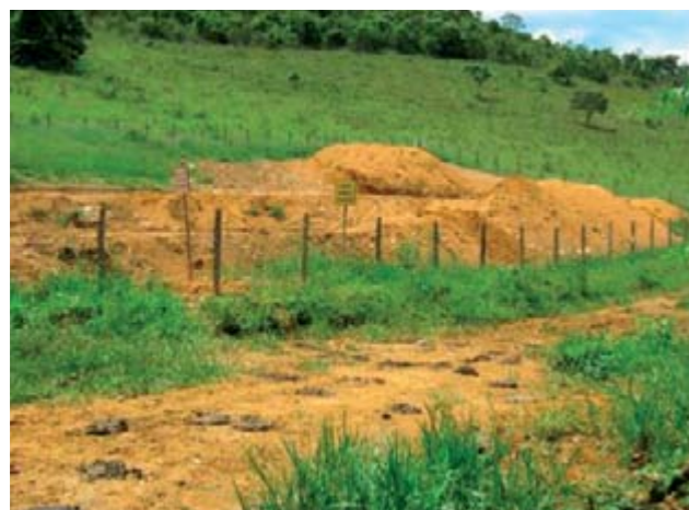
Figura 32 – Aterro controlado - vista 1.
