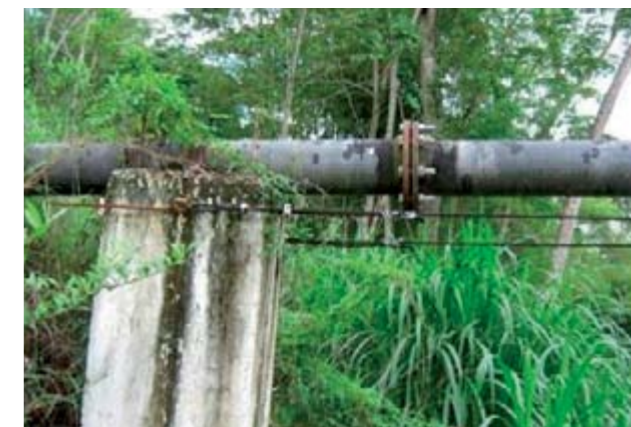
Figura 19 – EEAB – Adução saída d=100mm
