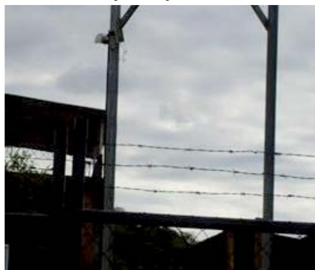
Figura 27 – Captação do poço tubular profundo vista 2
