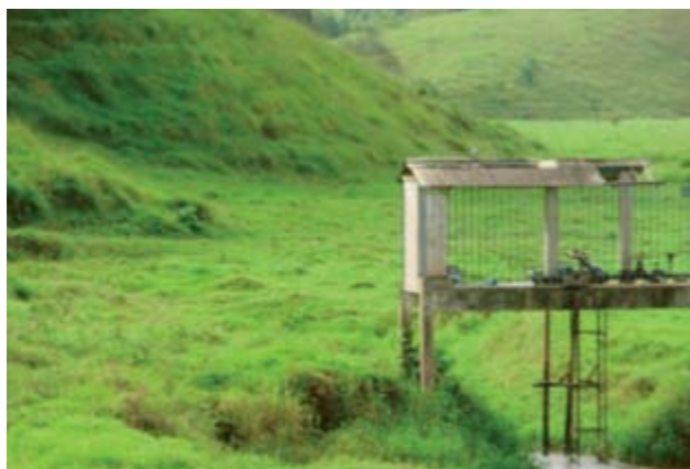
Figura 24 – Captação córrego da Fumaça vista 3
