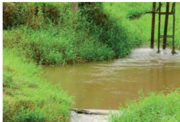
Figura 25 – Captação córrego da Fumaça vista 4
