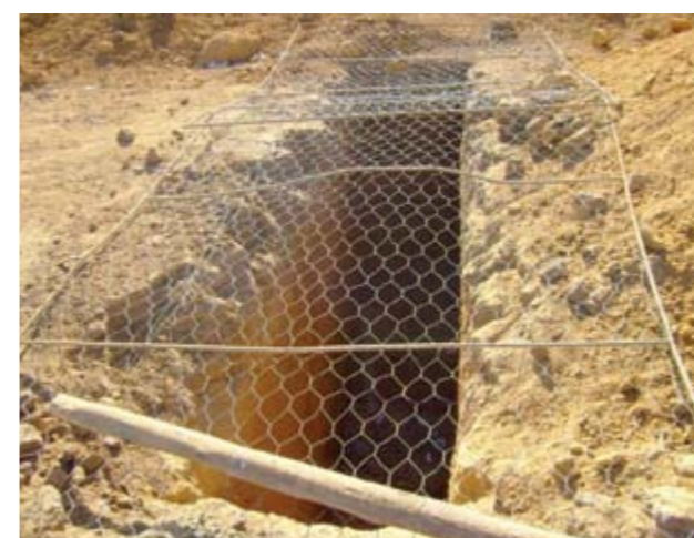
Figura 36 – Aterro controlado vista 3
