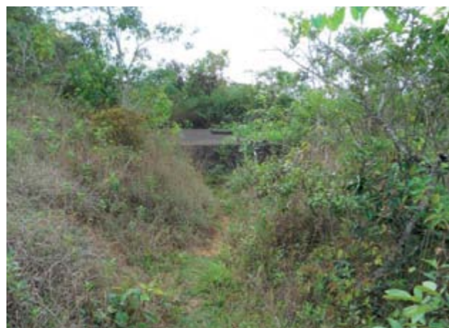
Figura 36 – Reservatório 240 m³ vista 1
