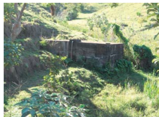
Figura 52 – Reservatório 110 m³ Ericeira vista 1.
