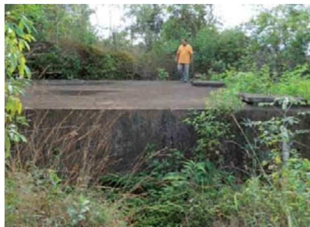
Figura 37 – Reservatório 240 m³ vista 2
