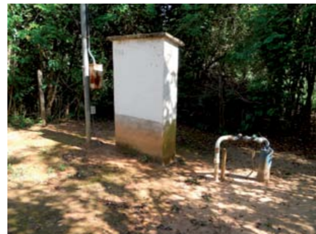
Figura 58 – Poço Rua Domiciliano Silva vista 1.
