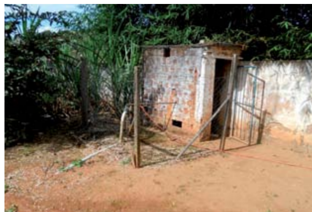
Figura 30 – Poço tubular profundo Fazenda Santana vista 1
