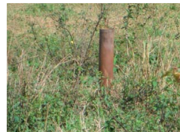
Figura 45 – Poço tubular inoperante vista 2
