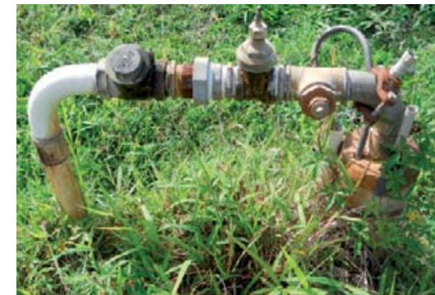
Figura 35 – Poço Câmara Municipal vista 2.
