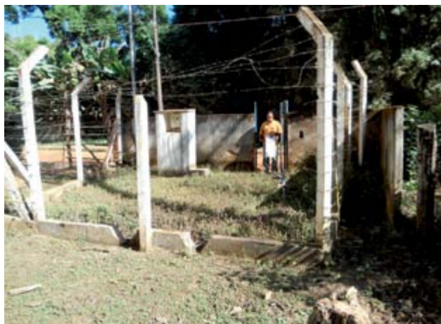
Figura 54 – Poço Rua Milton Monteiro da Silva vista 1.
