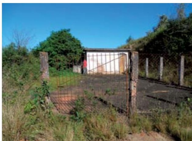
Figura 49 – Reservatório 240 m³ vista 2.
