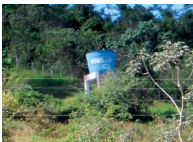
Figura 57 – Reservatório do poço.
