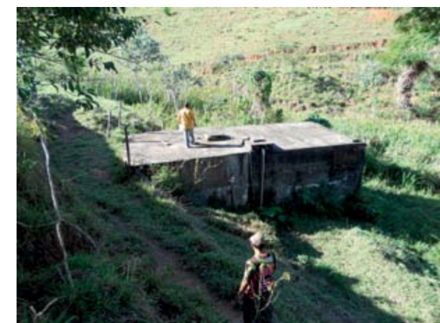
Figura 53 – Reservatório 110 m³ Ericeira vista 2.
