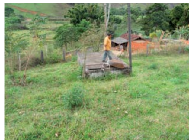
Figura 42 – Reservatório 10 m³ vista 1
