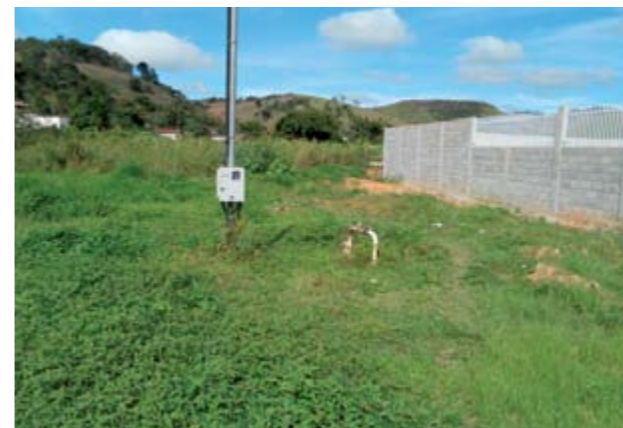
Figura 34 – Poço Câmara Municipal vista 1.
