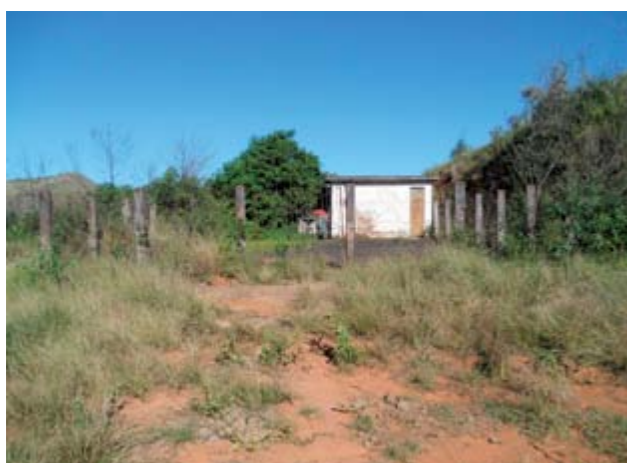
Figura 48 – Reservatório 240 m³ vista 1.
