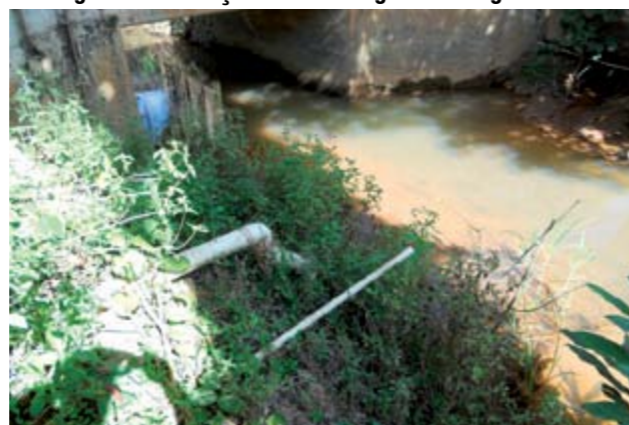
Figura 69 – Lançamento de esgoto Sossego vista 2
