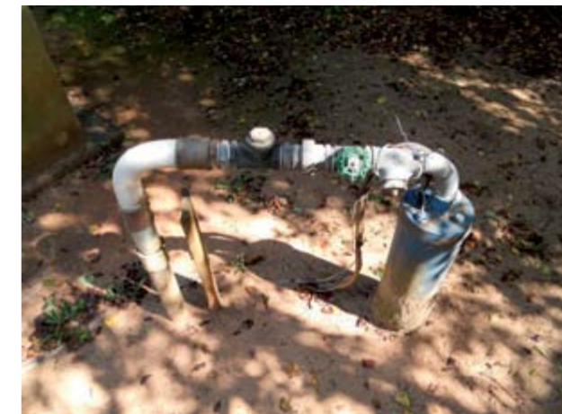
Figura 59 – Poço Rua Domiciliano Silva vista 2.
