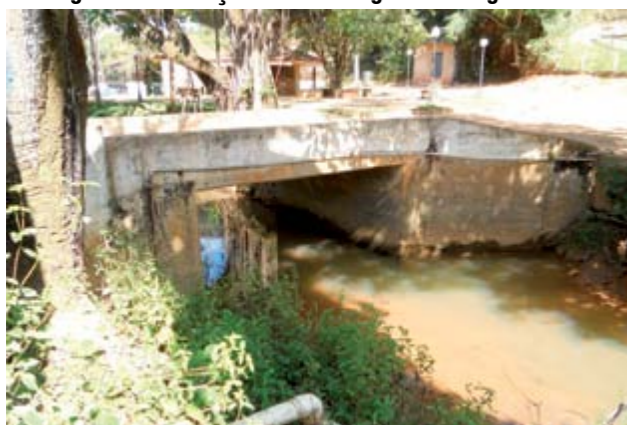
Figura 68 – Lançamento de esgoto Sossego vista 1
