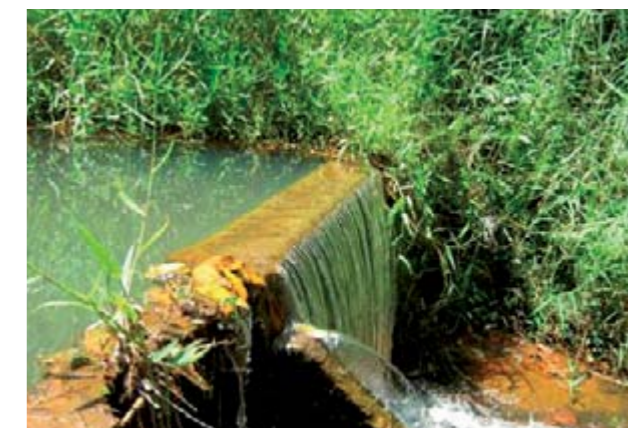
Figura 24 – Barragem de nível vista 2.
