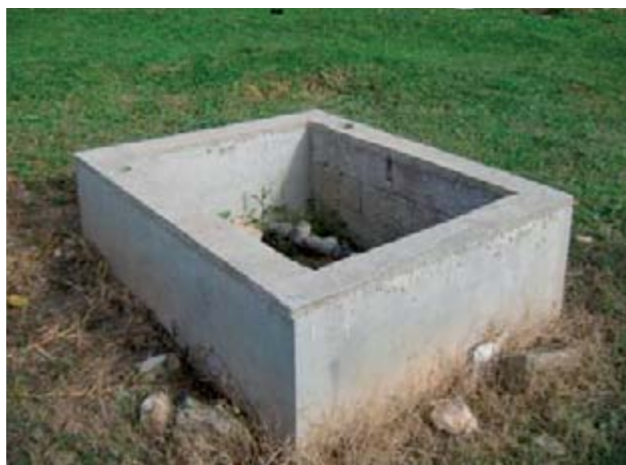
Figura 28 – Vista do Poço 2.
