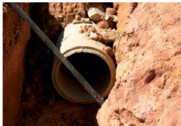
Figura 54 – Implantação de rede pluvial vista 2.
