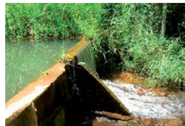
Figura 23 – Barragem de nível vista 1.
