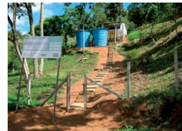
Figura 32 – Acesso a ETA.
