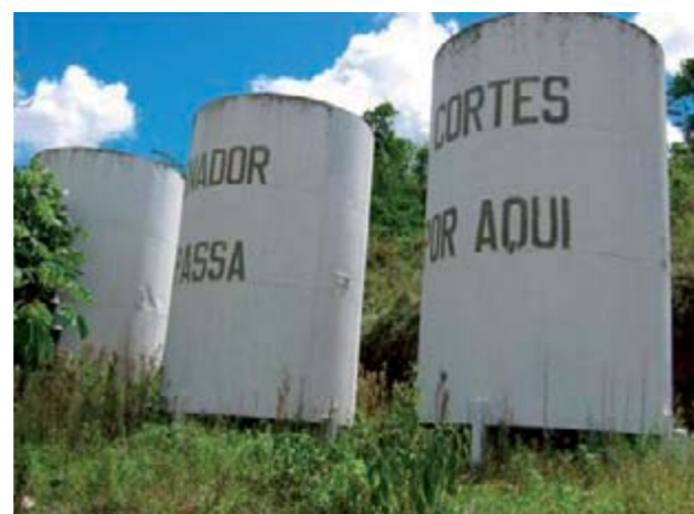
Figura 36 – Conjunto de reservatório vista 2.
