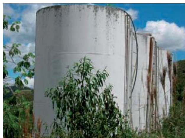
Figura 35 – Conjunto de reservatório vista 1.
