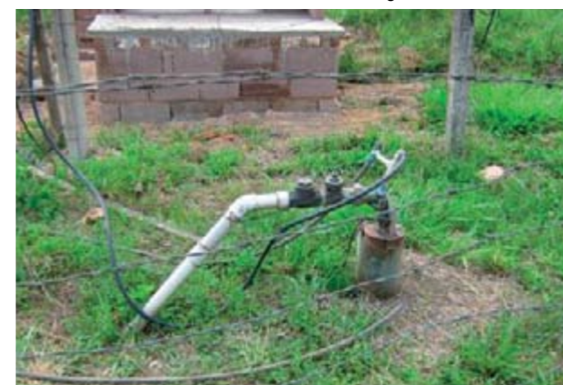
Figura 25 – Vista do Poço 1.
