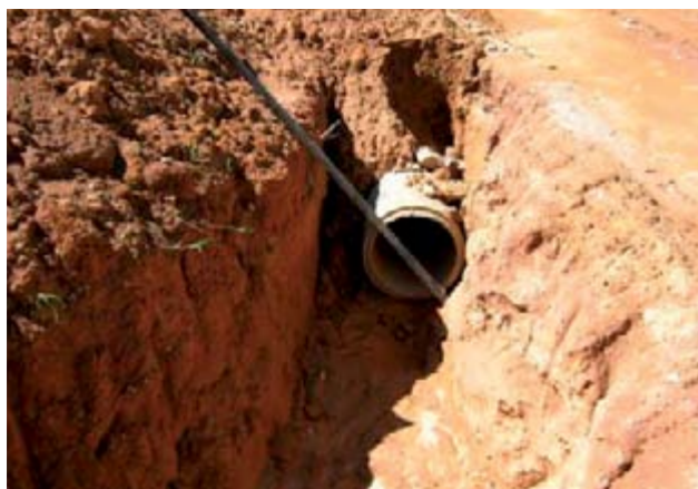
Figura 53 – Implantação de rede pluvial vista 1.
