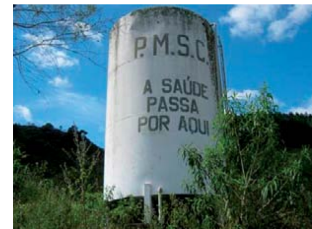
Figura 40 – Reservatório bairro Novo Horizonte vista 2.
