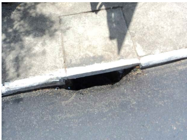
Figuras 4.3.1 e 4.3.2 - Sistema de drenagem – bocas de lobo.
