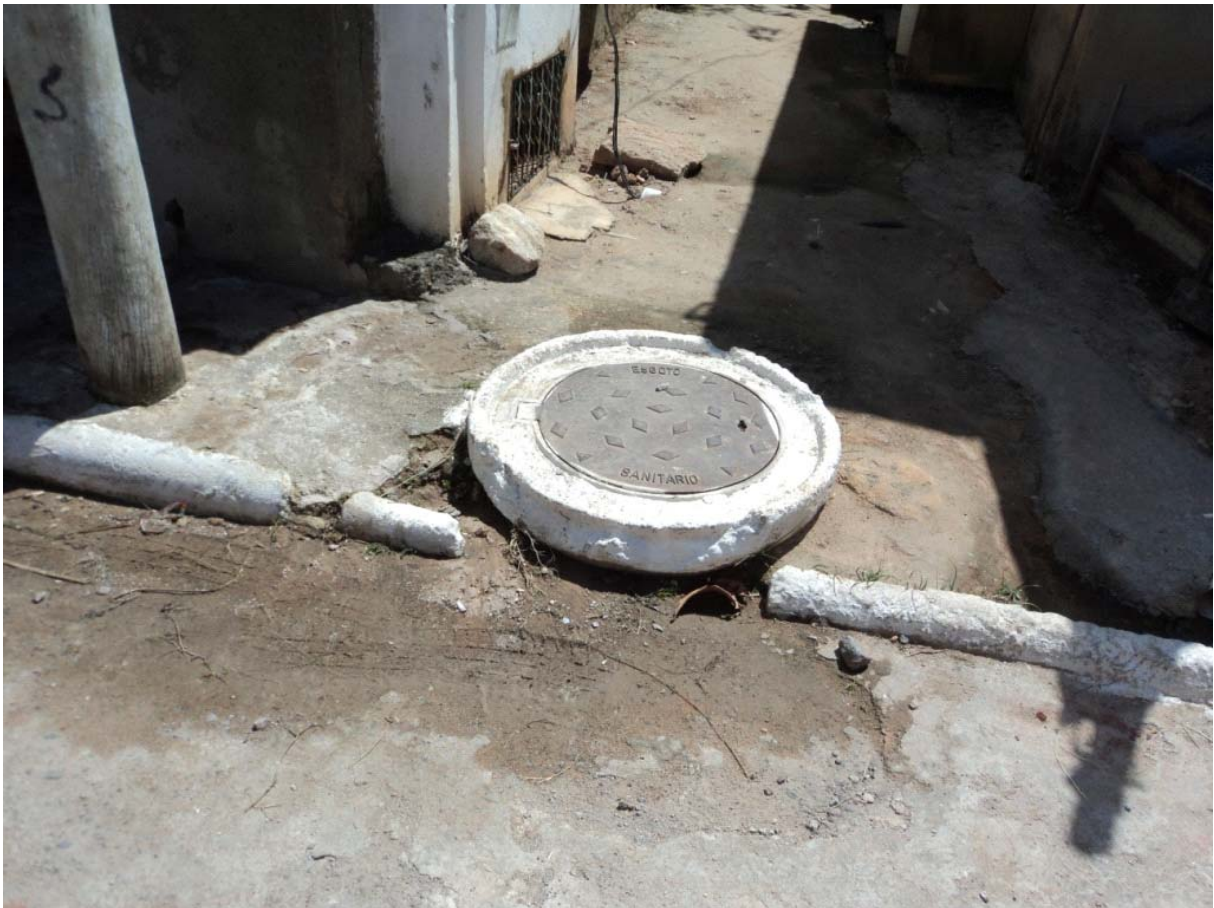
Figura 4.2.5 - Sistema Individual de Tratamento.
