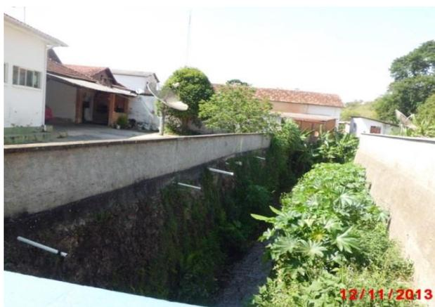
Figura 44: Lançamento de esgoto diretamente no córrego que corta a sede.
