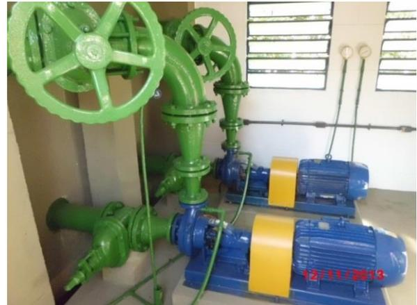
Figura 25: Elevatória de água tratada
