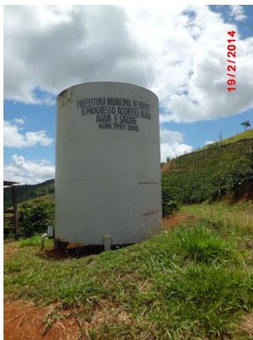
Figura 27: Reservatório em Viletes. Fonte: Conen
