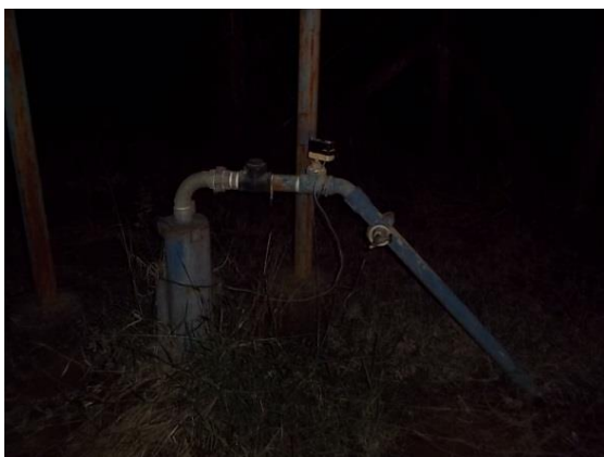
Figura 16: Captação por poço em Viletas. Fonte: Conen
