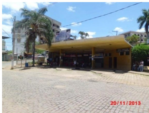
Figura 34: Exemplo de pavimentação no Município de Divino Fonte: Conen
