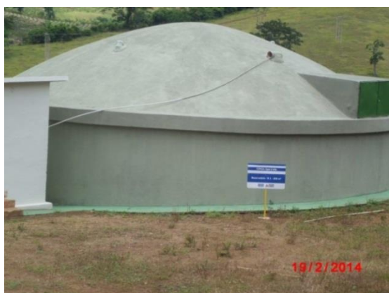
Figura 22: Reservatório R-01. Fonte: Conen
