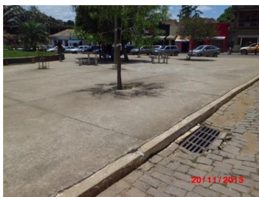
Figura 38: Identificação de estruturas de drenagem na praça principal da cidade Fonte: Conen
