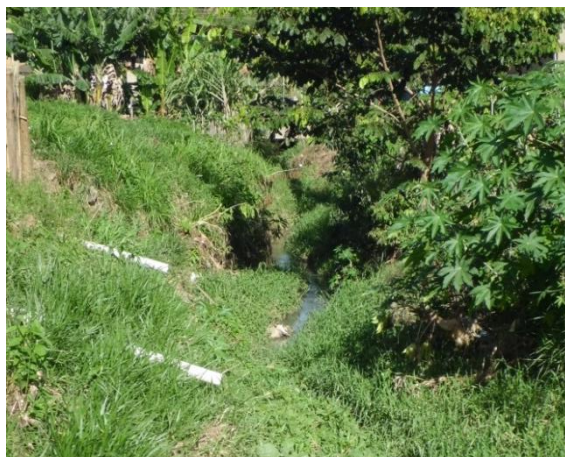
Figura 31: Área com grande contribuição de esgoto Fonte: Conen
