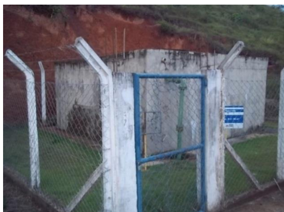
Figura 24: Reservatório R-03. Fonte: Conen
