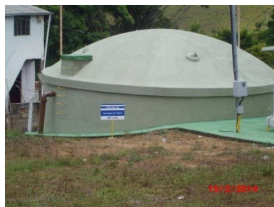
Figura 23: Reservatório R-02 Fonte: Conen
