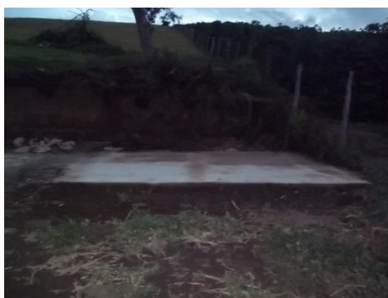
Figura 26: Reservatório R-05. Fonte: Conen
