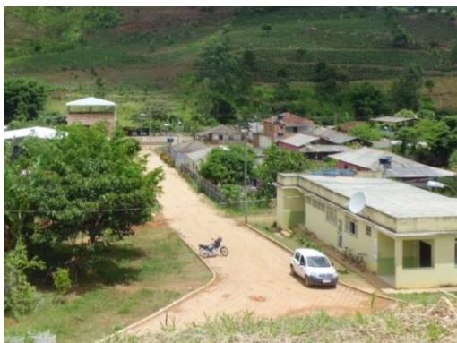
Figura 33: Exemplo de pavimentação no Município de Divino Fonte: Conen
