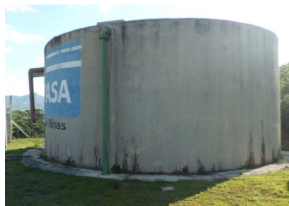
Figura 25: Reservatório R-04. Fonte: Conen
