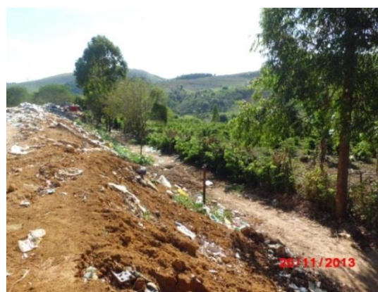
Figura 42: Talude formado pelo aterramento de resíduos no Aterro Controlado de Divino Fonte: Conen
