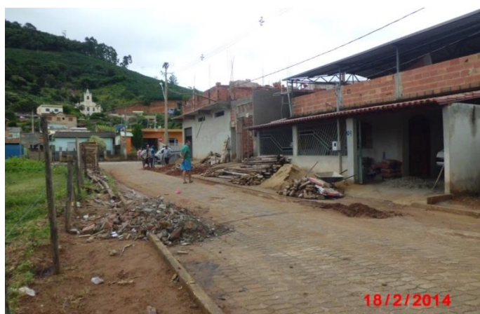
Figura 35: Execução de serviço de manutenção na rede pluvial Fonte: Conen
