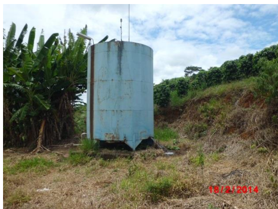
Figura 21: Reservatório em Vista Alegre. Fonte: Conen
