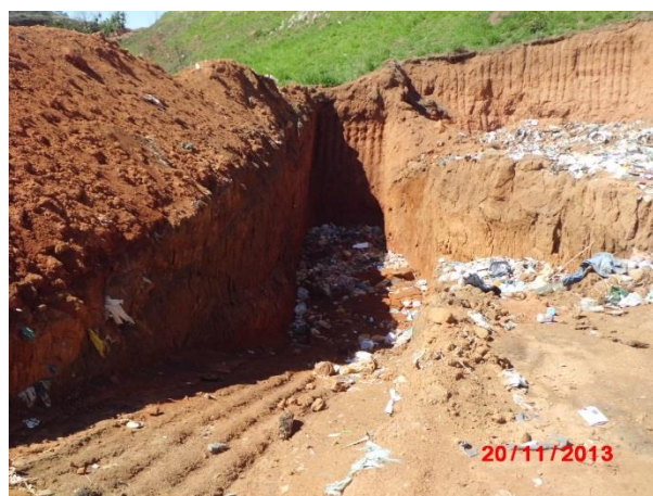
Figura 37: Vala de aterramento de resíduos no aterro controlado de Orizânia Fonte: Conen
