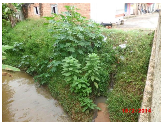
Figura 25: Córrego que possui lançamento de esgotamento sanitário. Fonte: Conen
