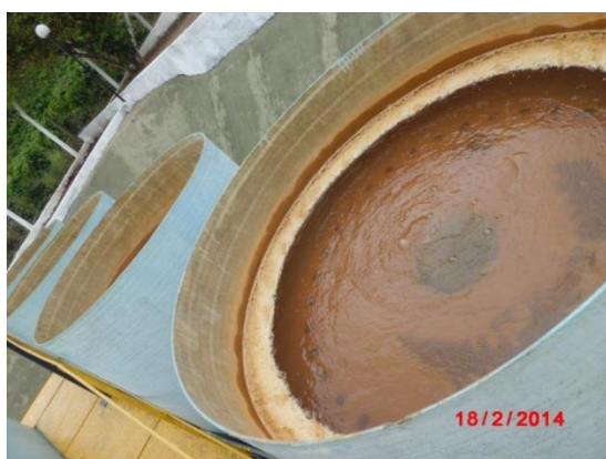
Figura 17: Floculador. Fonte: Conen
