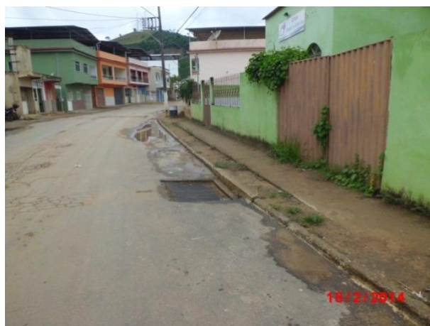
Figura 32: Identificação de bocas de lobo na localidade de Santa Bárbara Fonte: Conen
