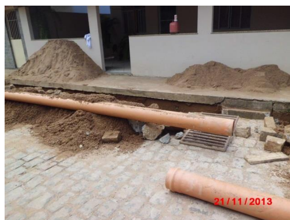
Figura 35: Manutenção de trecho de rede. Fonte: Conen
