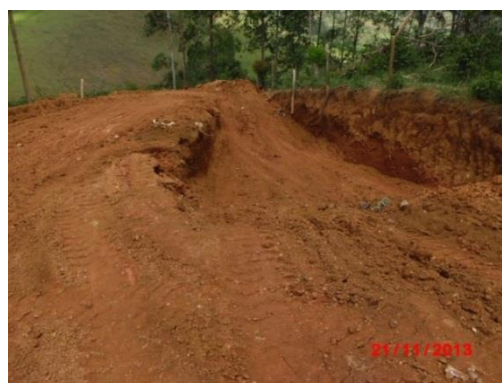
Figura 39: Vala de aterramento de resíduos. Fonte: Conen
