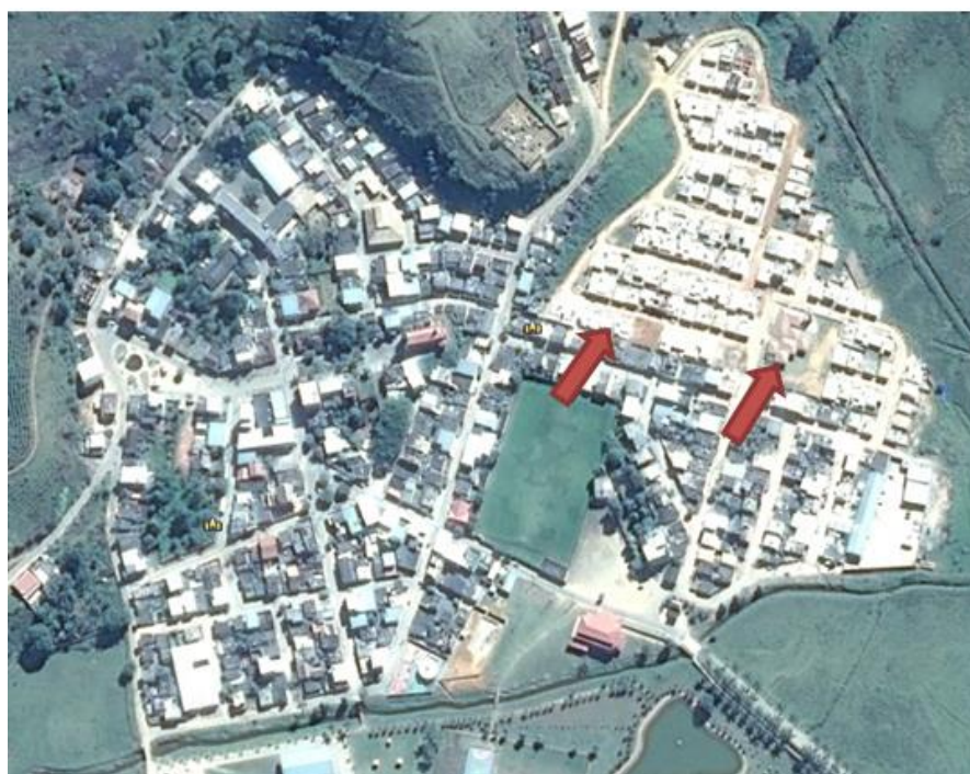
Figura 31: Indicação das áreas não pavimentadas na Sede Municipal de Pedra Dourada. Fonte: Conen
