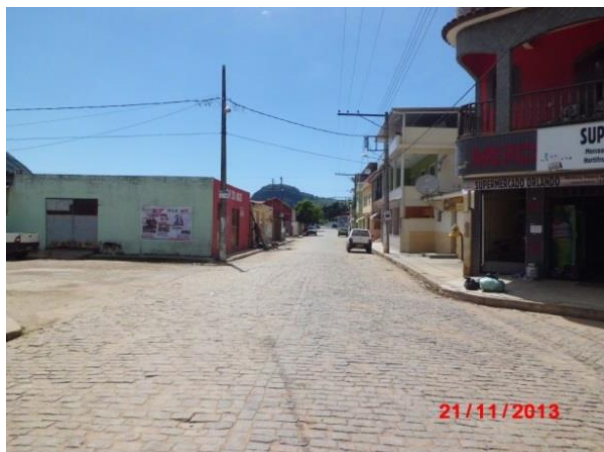
Figura 29: Exemplos de pavimentação no Município de Pedra Dourada. Fonte: Conen
