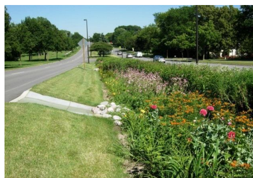
Figura 42: Grades verdes implantadas. Fonte: Bioretention/bioswale in median of Grange Avenue em Greendale, Winsconsin
