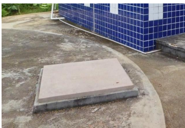
Figura 21: Reservatório R-01. Fonte: Conen
