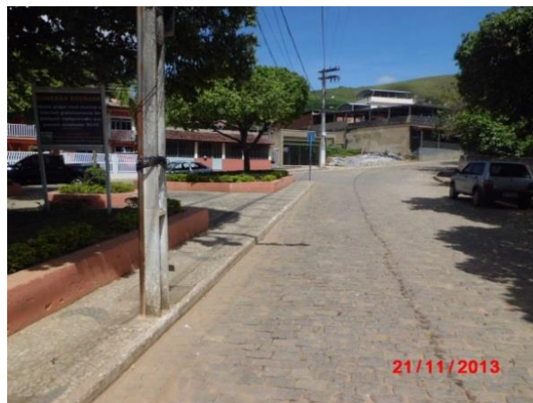
Figura 30: Exemplos de pavimentação no Município de Pedra Dourada. Fonte: Conen
