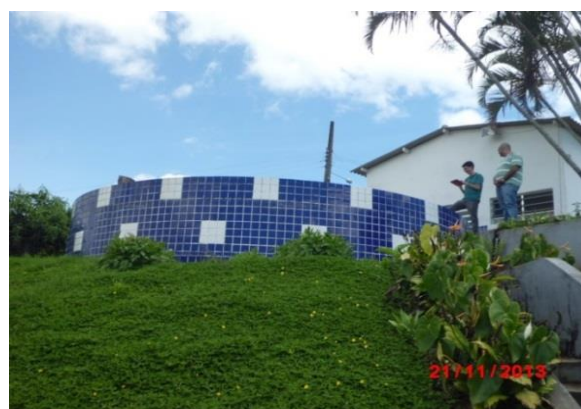
Figura 22: Reservatório R-02. Fonte: Conen
