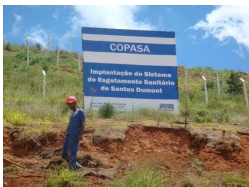
Figura 42: ETE em construção Fonte: Conen
