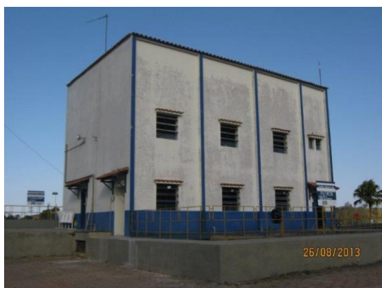
Figura 32: ETA Santos Dumont Fonte: COPASA
