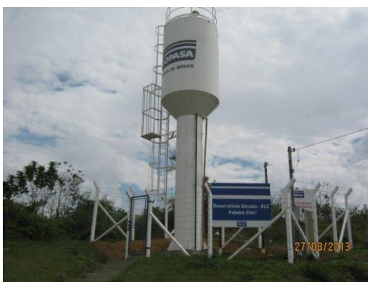
Figura 37: Reservatório Palmira Fonte: Conen
