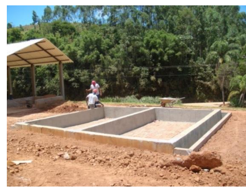
Figura 45: ETE em construção - área dos desodorizadores Fonte: Conen
