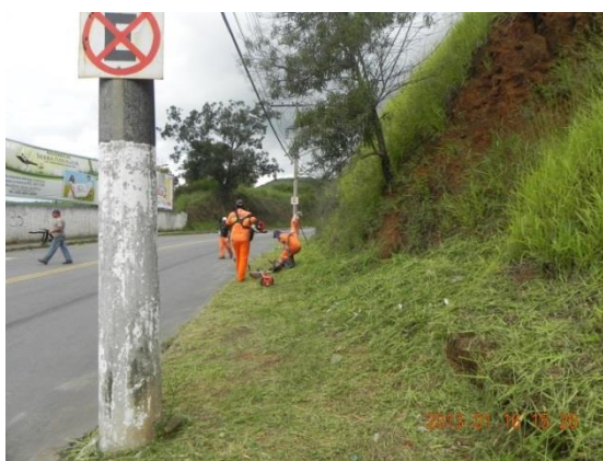
Figura 65: Limpeza da Rota 14 Bis Fonte: Prefeitura Municipal
