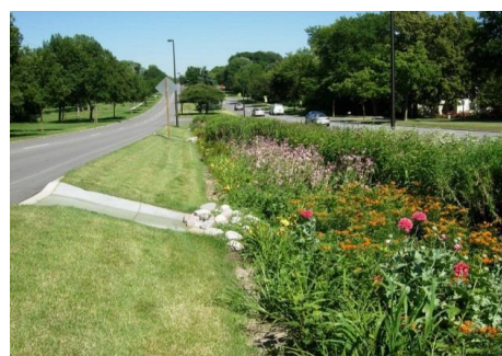
Figura 75: Grades verdes implantadas. Fonte: Bioretention/bioswale in median of Grange Avenue em Greendale, Winsconsin
