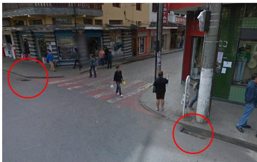
Figura 59: Identificação de bocas de lobo, Av. Presidente Getúlio Vargas, Centro de Santos Dumont Fonte: Google Street View
