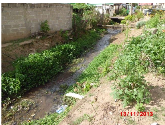
Figura 39: Lançamento de esgoto no Bairro Quarto Depósito Fonte: Conen
