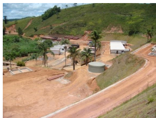
Figura 43: ETE em construção Fonte: Conen
