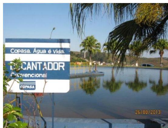
Figura 33: Decantador Fonte: COPASA
