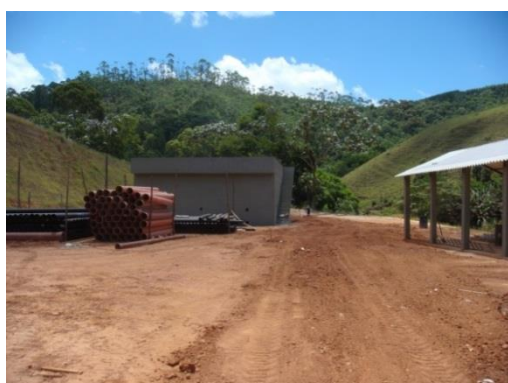
Figura 44: ETE em construção – filtro UASB Fonte: Conen
