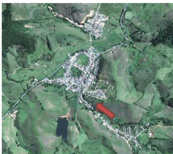
Figura 32: Indicação das áreas não pavimentadas na Sede Municipal de Tabuleiro Fonte: Conen
