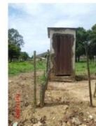
Figura 2: Poço artesiano no Distrito de Santa Rita do Botafogo Fonte: Conen
