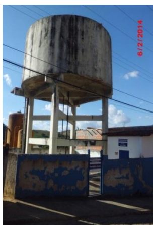
Figura 27: Reservatório elevado Fonte: Conen
