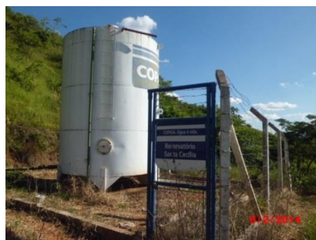
Figura 26: Reservatório Santa Cecília Fonte: Conen
