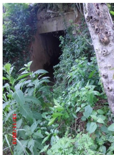
Figura 18: Descarte de esgoto próximo à captação d'água Fonte: Conen
