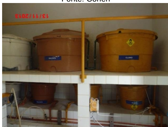
Figura 23: Tanques de preparo do flúor, hipoclorito de cálcio e sulfato Fonte: Conen
