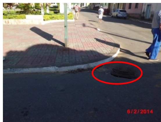
Figura 38: Boca de lobo próxima à praça Fonte: Conen
