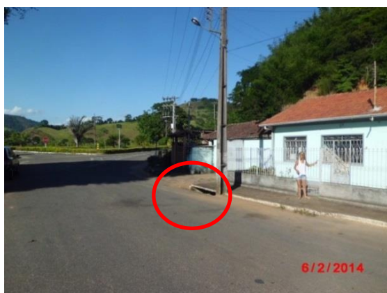
Figura 37: Boca de lobo Fonte: Conen
