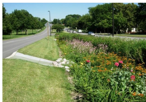
Figura 46: Grades verdes implantadas. Fonte: Bioretention/bioswale in median of Grange Avenue em Greendale, Winsconsin
