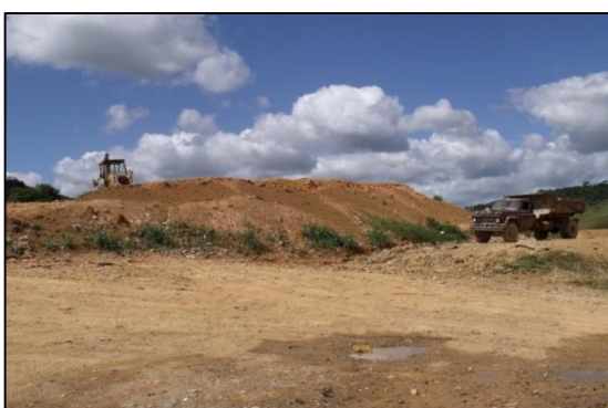
Figura 36– Vista do Aterro Controlado
