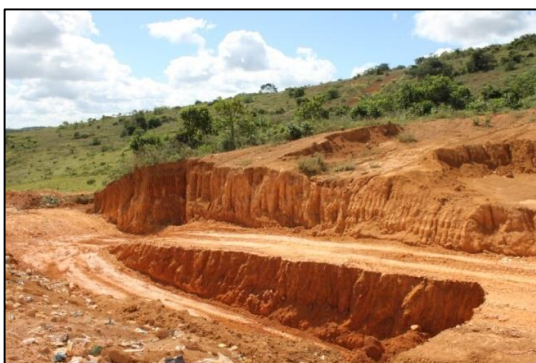
Figura 38 – Aterro Controlado e acessos
