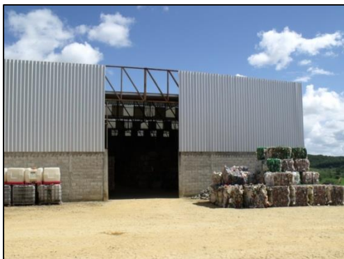
Figura 29 – Vista externa do Galpão de armazenamento
