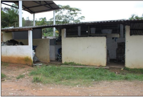
Figura 33 – Vista externa do Galpão de armazenamento
