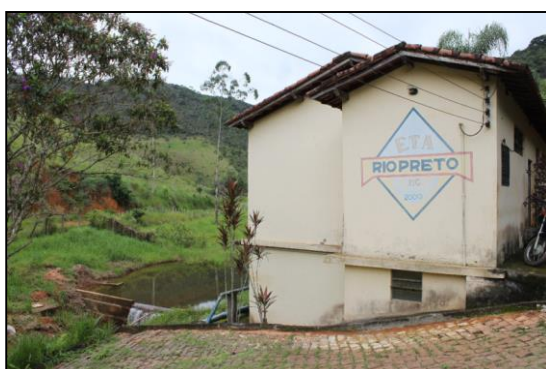
Figura 10 – Estação de Tratamento de Água (ETA)
