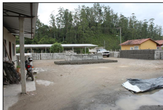
Figura 49 – Vista parcial da empresa de blocos, bloquetes e manilhas
