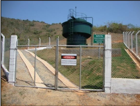
Figura 24 – Acesso a ETE Monte Serrat
