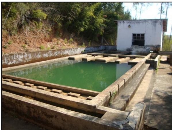
Figura 8 – Vista da ETA Fábrica
