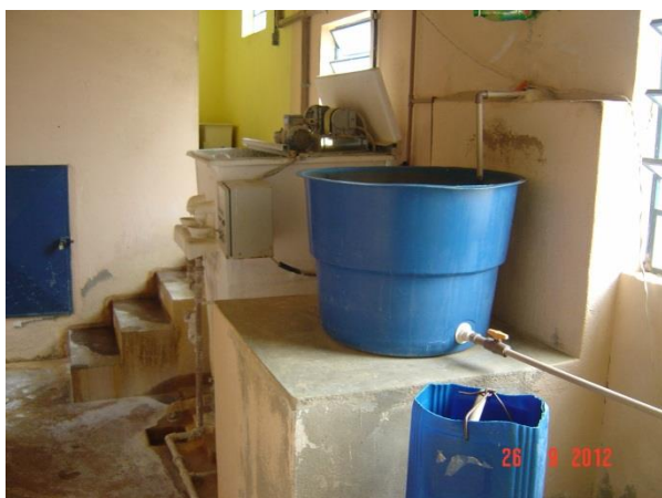
Figura 12 – Vista da casa de química
