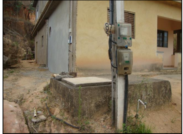
Figura 19 – Detalhe da cisterna – bairro Reta
