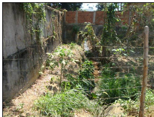
Figura 29 – Córrego no loteamento Raio do Sol que recebe esgoto
