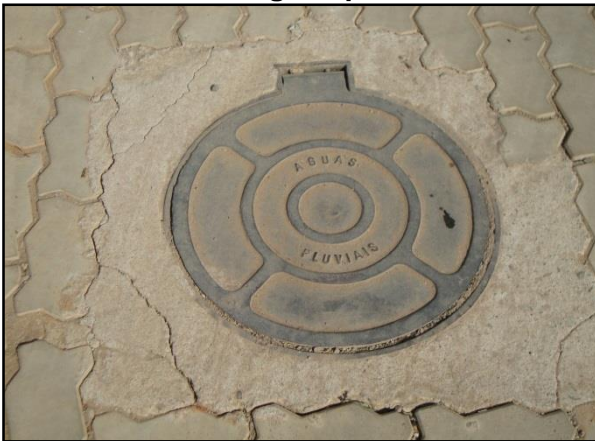
Figura 38 – Vista do tampão do PV da rede de águas pluviais
