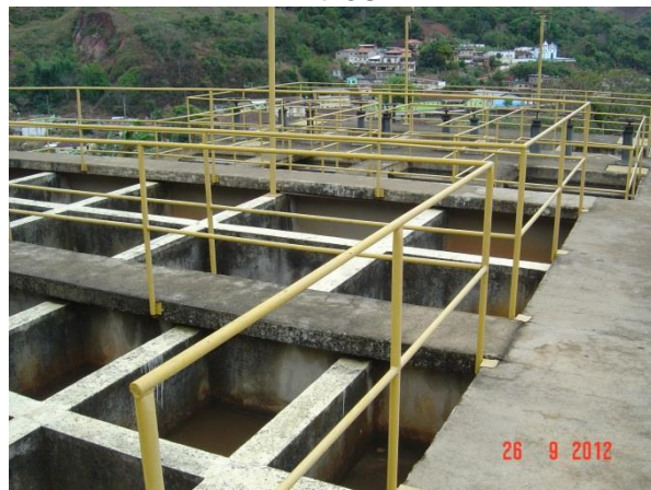
Figura 11 – Vista dos decantadores e filtros
