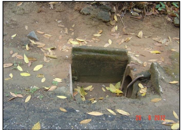
Figura 39 – Vista da tubulação de coleta de águas pluviais
