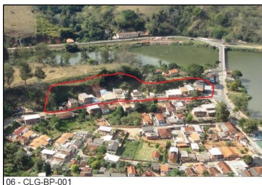
Figura 44 – Área de risco no bairro Mont Serrat na R. Bernardino Franco
