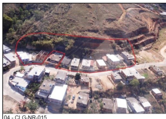
Figura 43 – Área de risco no bairro Fonseca Almeida na Av. Reginaldo Maia
