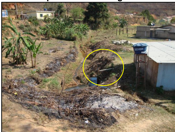
Figura 30 – Lançamento das águas pluviais em córrego
