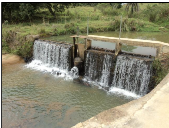
Figura 7 – Barragem de nível vista 1
