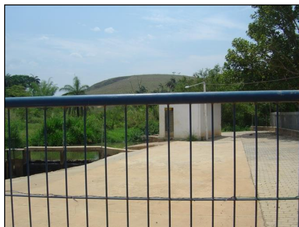
Figura 10 – Estação elevatória de água bruta
