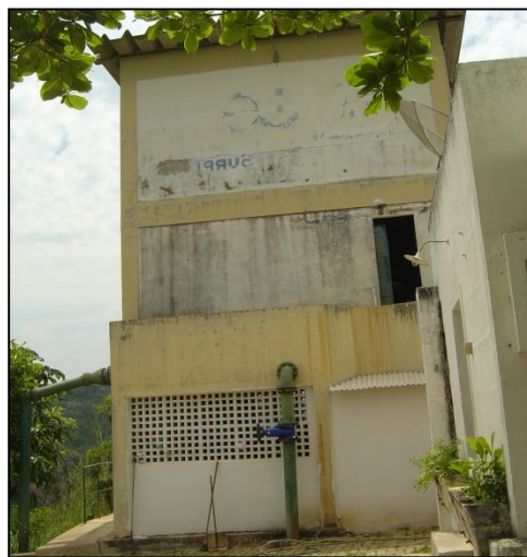
Figura 24 - Vista da ETA Avelar 2
