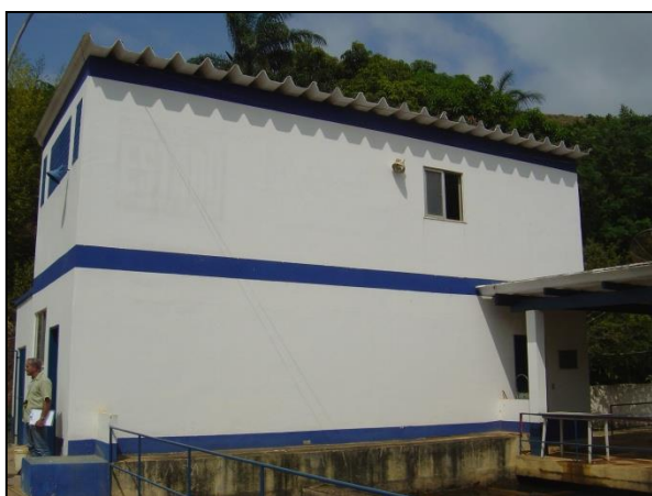
Figura 13 – Vista 1 da ETA Paty
