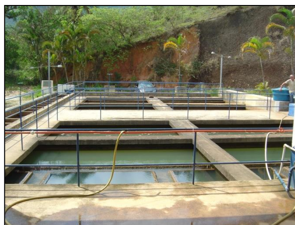
Figura 14 – Vista 2 da ETA Paty
