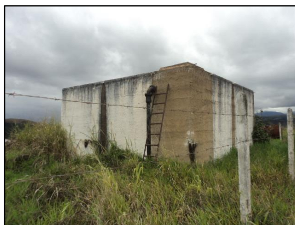
Figura 26 – Reservatório do Morro João Malandro
