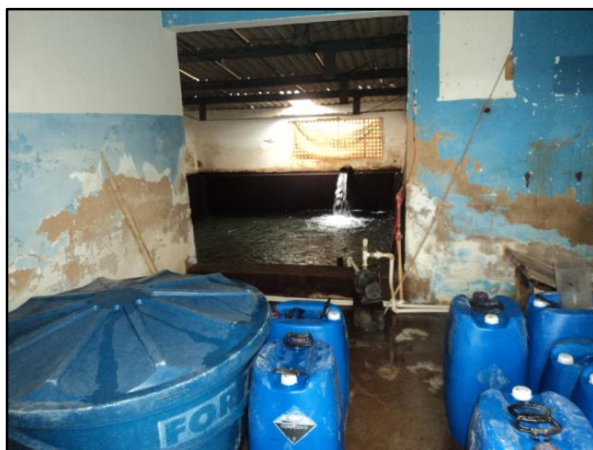
Figura 25 – Reservatório ETA Avelar
