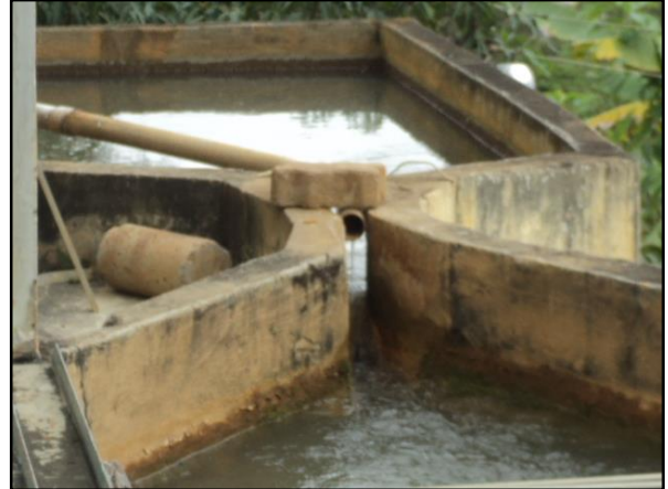
Figura 16 – Adição de agente coagulante
