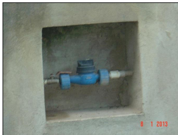
Figura 28 – Ligação com hidrômetro
