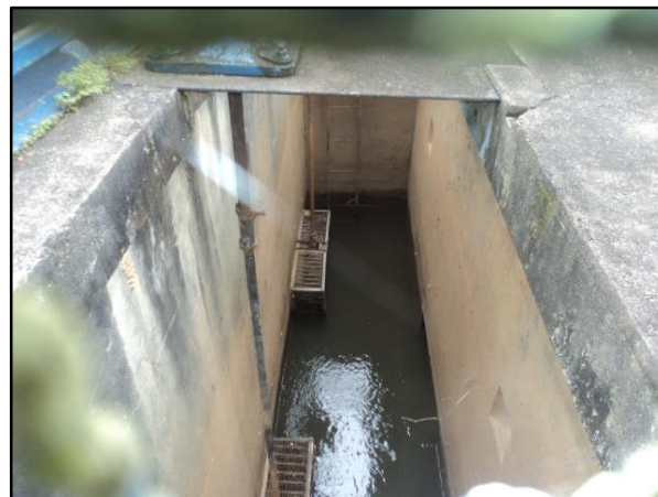
Figura 9 – Local de armazenamento junto à captação no Rio Paraíba do Sul (Vista 2)
