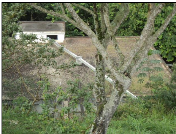
Figura 20 – Reservatório anexo à ETA Pinheiral
