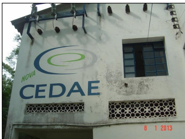
Figura 10 – Estação Elevatória de Água Bruta
