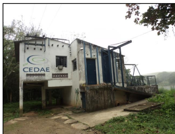
Figura 7 – Estação Elevatória responsável pela captação no Rio Paraíba do Sul
