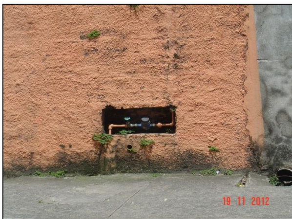
Figura 27 – Ligação com hidrômetro
