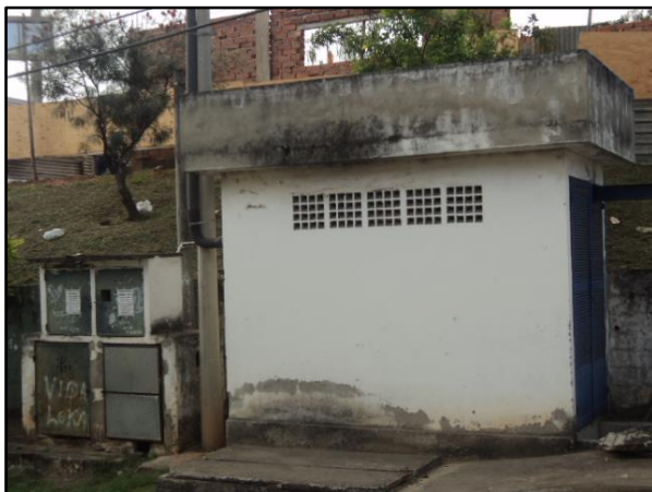
Figura 12 – Estação Elevatória de Água Tratada (Vista 1)
