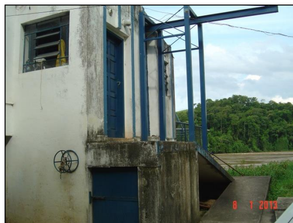
Figura 11 – Estação Elevatória de Água Bruta
