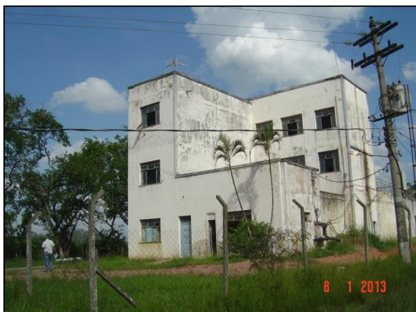
Figura 21 – Cerca da ETA Pinheiral
