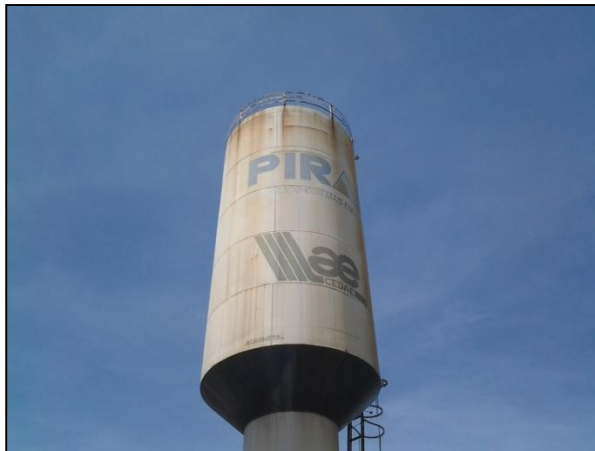
Figura 51 – Reservatório Morro do Cruzeiro
