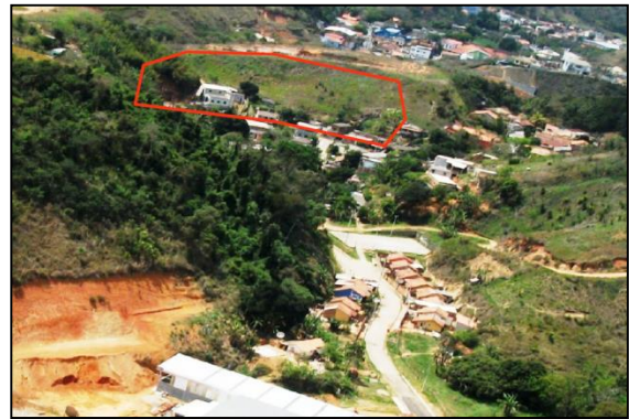
Figura 86 – Área de risco na Rua Santa Teresa
