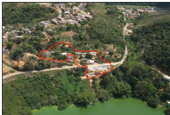
Figura 78 – Área de risco na Rua A.
