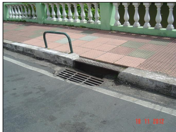
Figura 76 – Boca de lobo em bom estado de conservação 4
