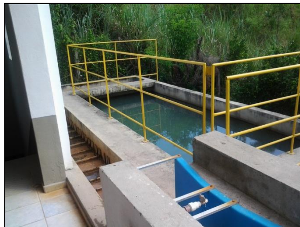
Figura 25 – Vista da ETA Rosa Machado
