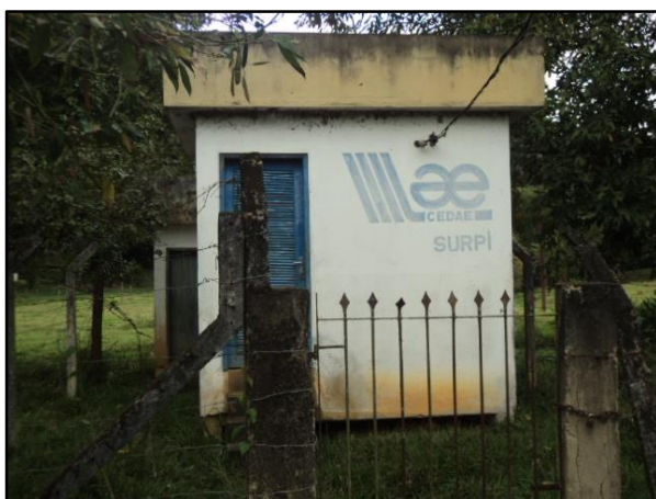
Figura 16 – EEAB do Ribeirão Varjão no distrito de Arrozal - vista 1
