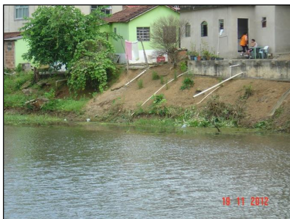
Figura 71 – Córrego que recebe águas pluviais
