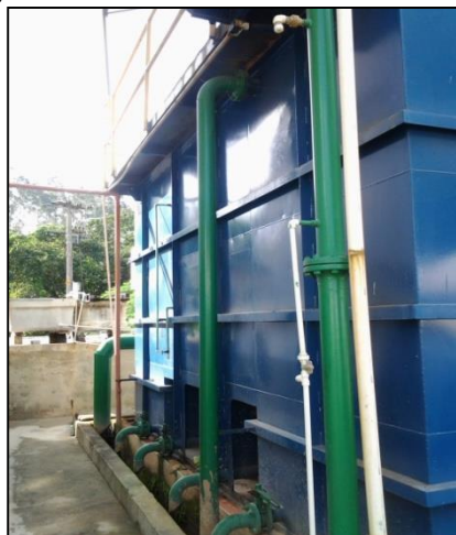
Figura 23 – Vista da ETA Santanésia
