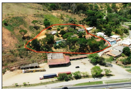
Figura 82 – Área de risco na Rua A, 65
