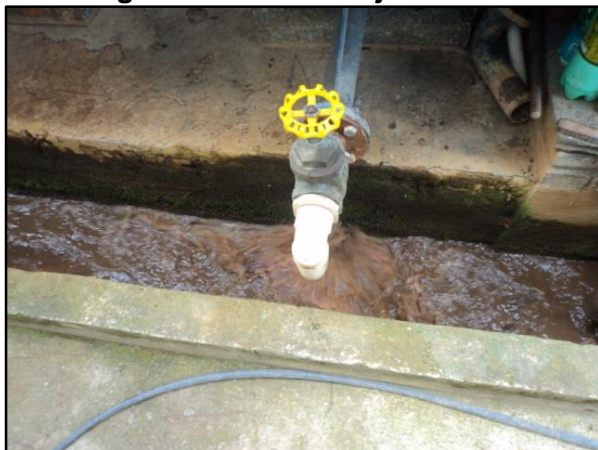
Figura 33 – ETA Varjão vista 7
