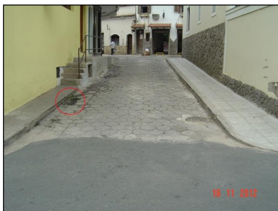
Figura 73 – Boca de lobo em bom estado de conservação 1
