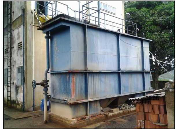
Figura 36 – Vista da ETA Varjão
