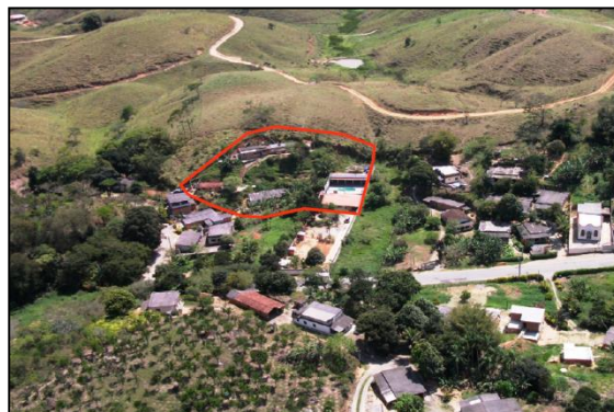
Figura 90 – Área de risco na Rua Antônio da Rosa Machado Júnior
