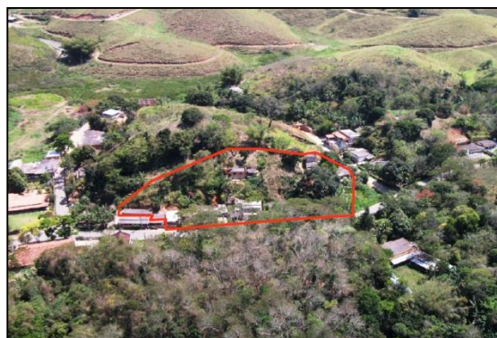
Figura 80 – Área de risco na Rua Rosa Machado
