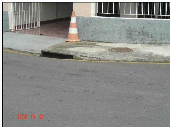
Figura 75 – Boca de lobo em bom estado de conservação 3
