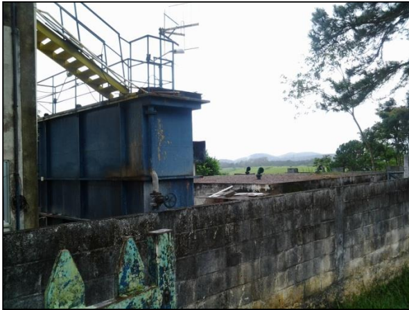
Figura 35 – Vista da ETA Varjão
