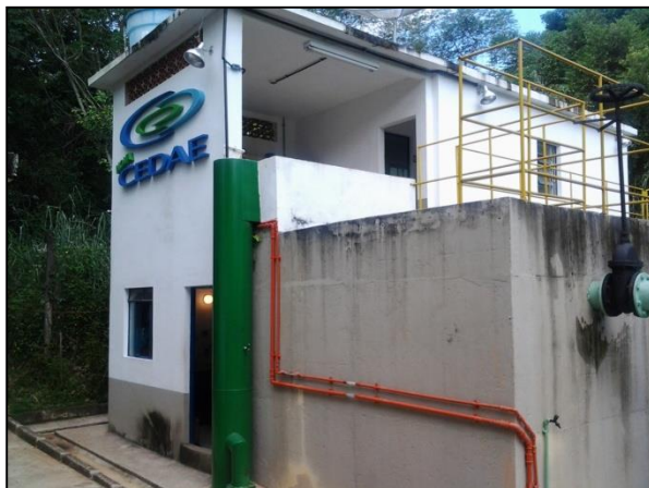
Figura 24 – Vista da ETA Rosa Machado
