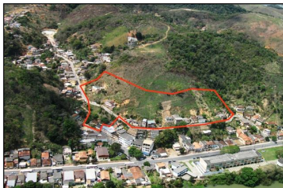
Figura 77 – Área de risco na Rua Simão Antônio Vaz
