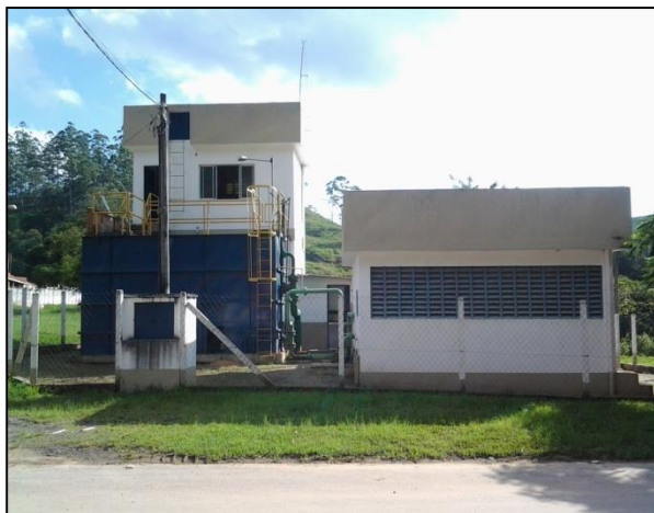
Figura 22 – Vista da ETA Santanésia
