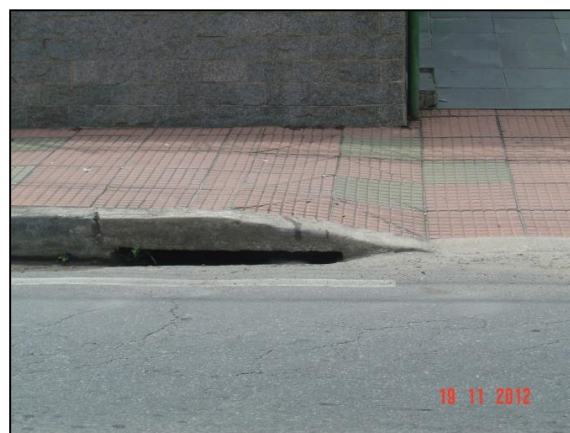
Figura 74 – Boca de lobo em bom estado de conservação 2
