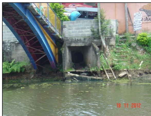
Figura 72 – Córrego que recebe águas pluviais
