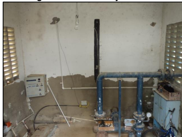
Figura 34 – ETA Varjão vista 8
