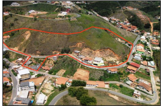
Figura 84 – Área de risco na Rua Ivan Vernon
