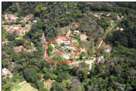
Figura 89 – Área de risco na Rua da Represa, 651
