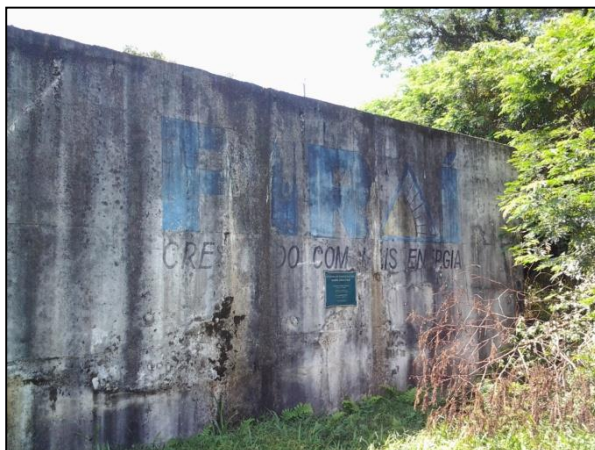
Figura 47 – Reservatório Morro do Asilo
