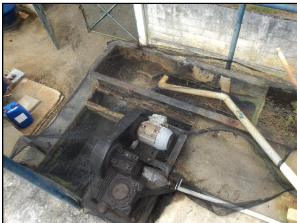
Figura 28 – ETA Varjão vista 1
