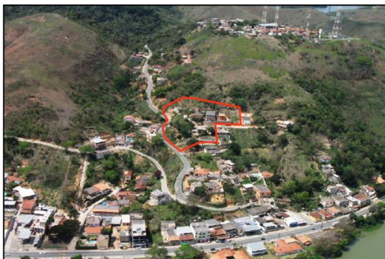
Figura 87 – Área de risco na Rua Subida do Sarole
