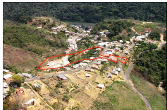
Figura 88 – Área de risco na Rua do Campinho (bairro Sossego II)
