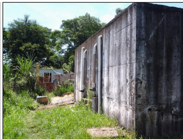
Figura 48 – Reservatório Morro do Asilo
