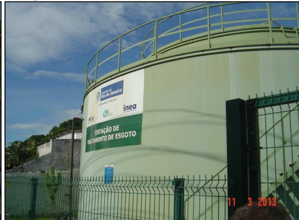
Figura 66 – Vista da ETE sub-bacia D
