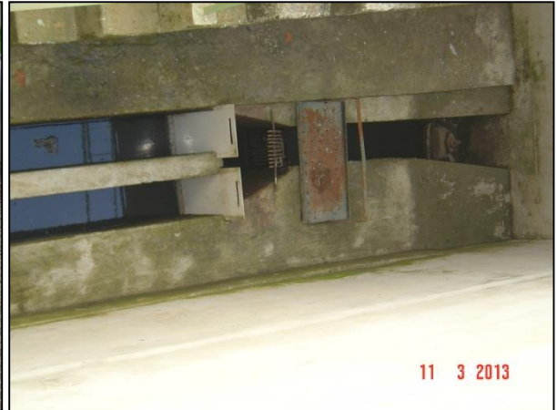
Figura 64 – Sistema primário da ETE sub-bacia A.
