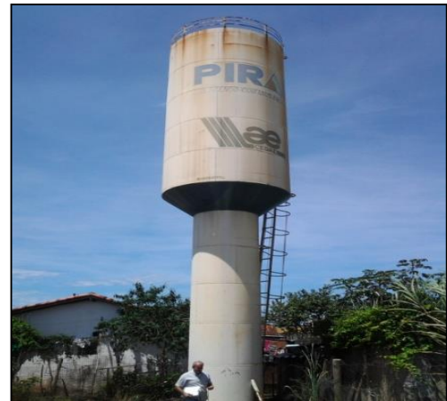
Figura 52 – Reservatório Morro do Cruzeiro
