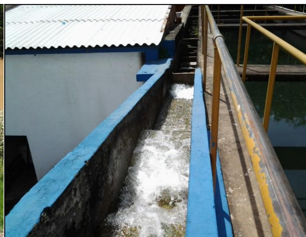
Figura 19 – Vista da ETA Pirai
