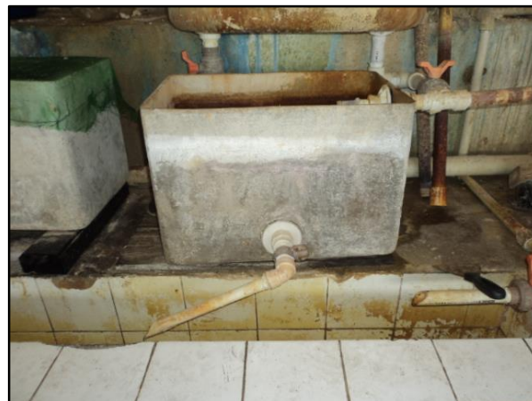
Figura 29 – ETA Varjão vista 2
