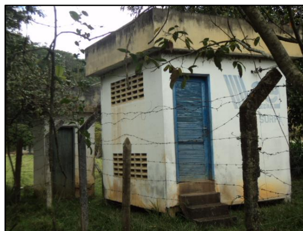
Figura 17 – EEAB do Ribeirão Varjão no distrito de Arrozal - vista 2
