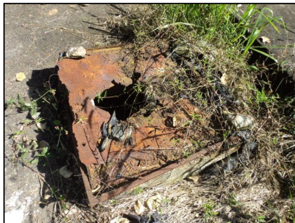
Figura 30 – Detalhe da tampa da fossa séptica
