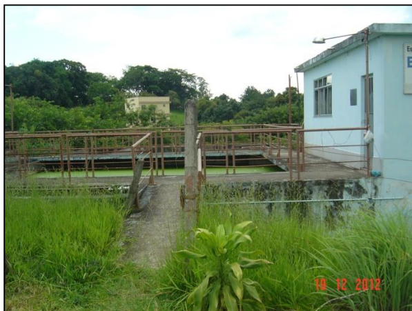
Figura 21 – Situação do entorno da ETE Barrinha
