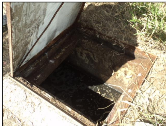
Figura 27– Fossa séptica desativada no distrito Falcão
