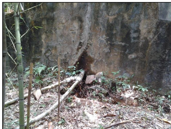
Figura 18 – Reservatório R04 - vista 2
