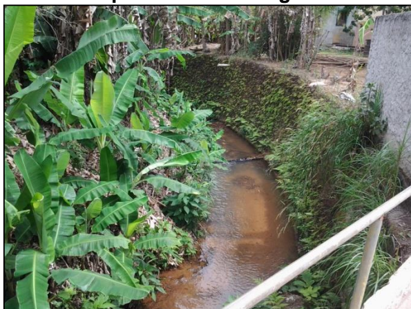
Figura 46 – Lançamento das águas pluviais em córrego
