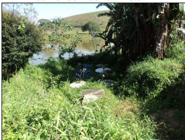
Figura 44 – Fossa séptica final no distrito de Manuel Duarte – vista 1
