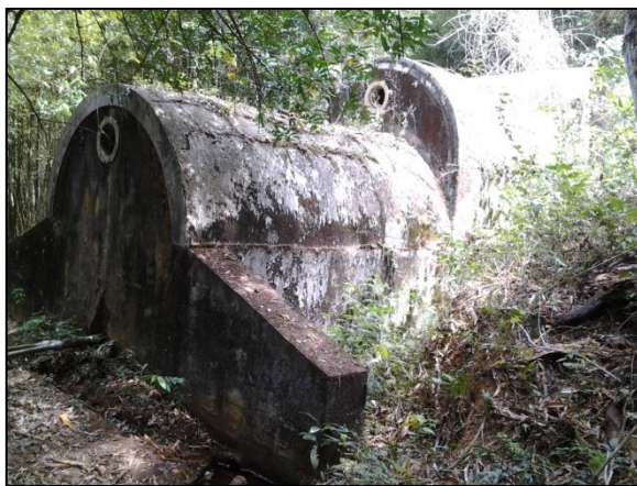
Figura 17 – Reservatório R04 - vista 1
