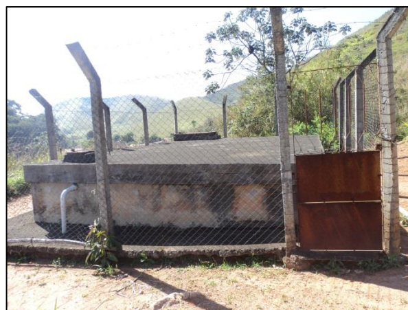
Figura 24 – Reservatório R13 - vista 2
