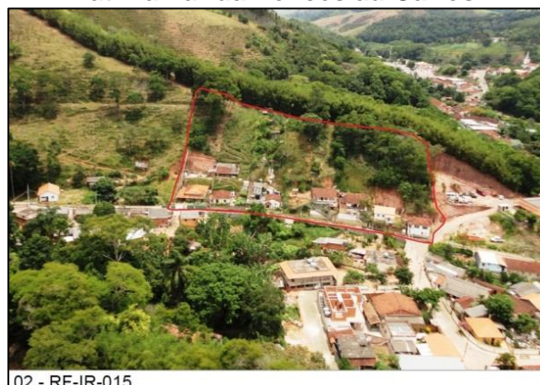
Figura 55 – Área de risco no bairro de Fátima na rua Venceslau Carlos
