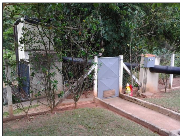
Figura 35 – ETE do Baixinho – vista 1
