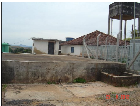
Figura 9 – Vista da ETA Solidão 1
