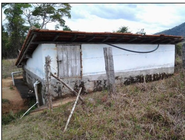
Figura 23 – Reservatório R13 - vista 1
