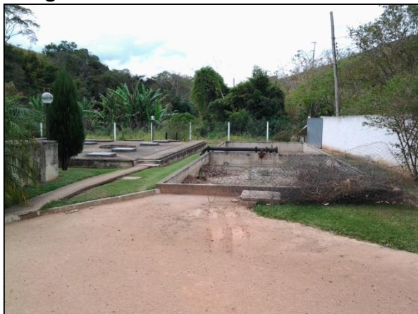
Figura 36 – ETE do Baixinho – vista 2
